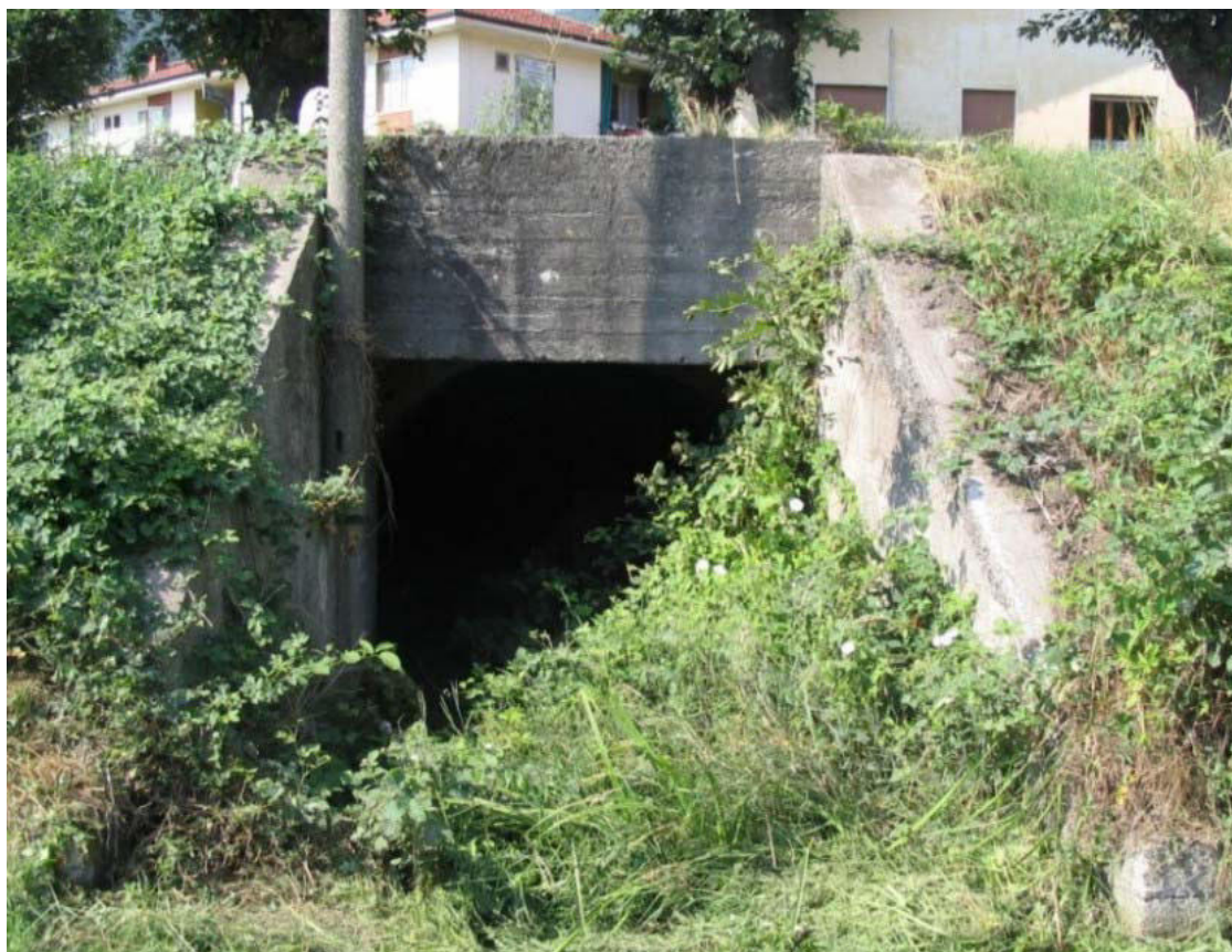
Foto 169 –Opera PENNCA033 . Ripresa frontale dell'imbocco a monte.
