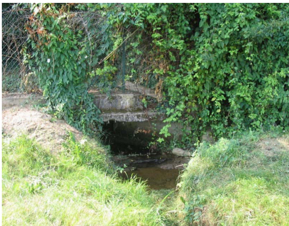
Foto 164 A – Opera CANOCA010 . Ripresa dell'imbocco a monte..
