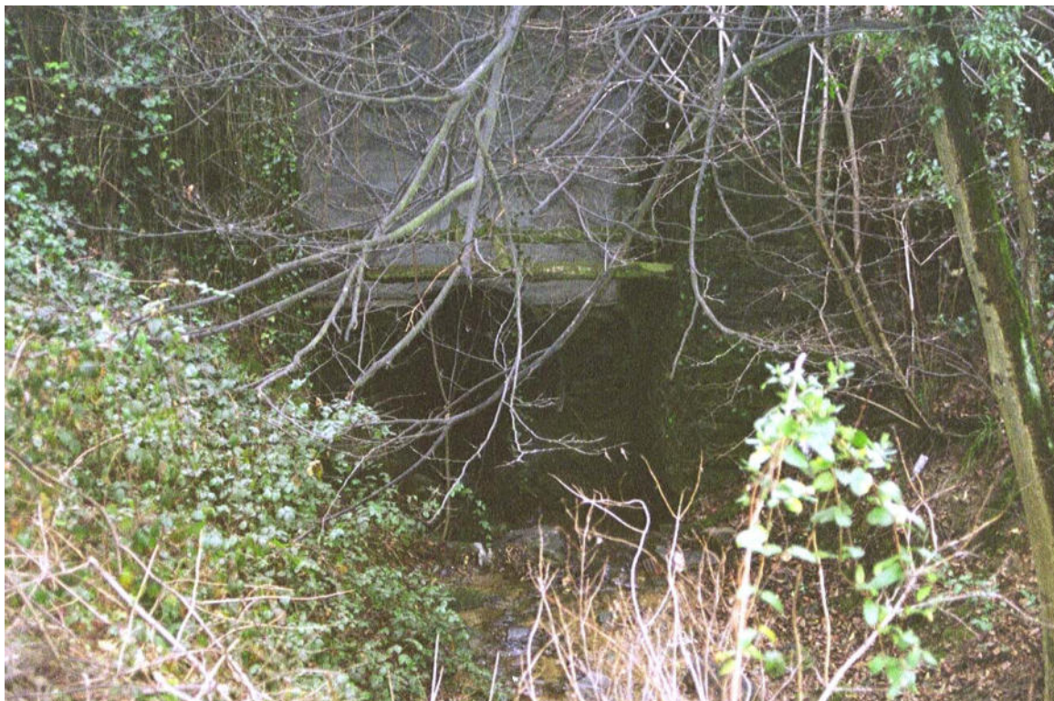
Foto 017 – Opera CANOSO007 . Ripresa da monte verso valle, Canale dei Mantelli, affluente di sinistra del T. Pellice.
