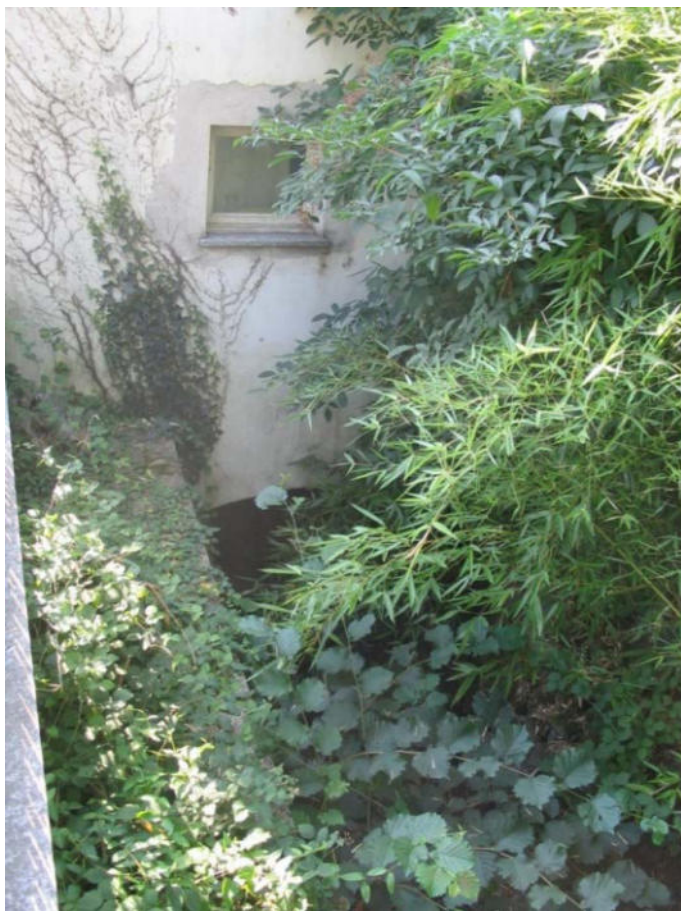
Foto 166 – Opera CANOCA016 . Ripresa da monte, dal muro di sponda CANODS043.
