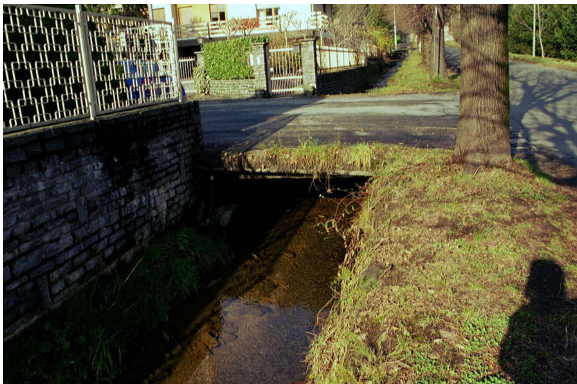
Foto 021 – Opera CANOAG014 . Ripresa da valle, sponda sinistra del Canale dei Mantelli.
