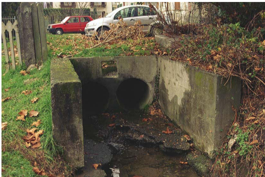
Foto 164 B – Opera CANOCA010 . Ripresa frontale dello sbocco a valle nel Canale della Stazione.
