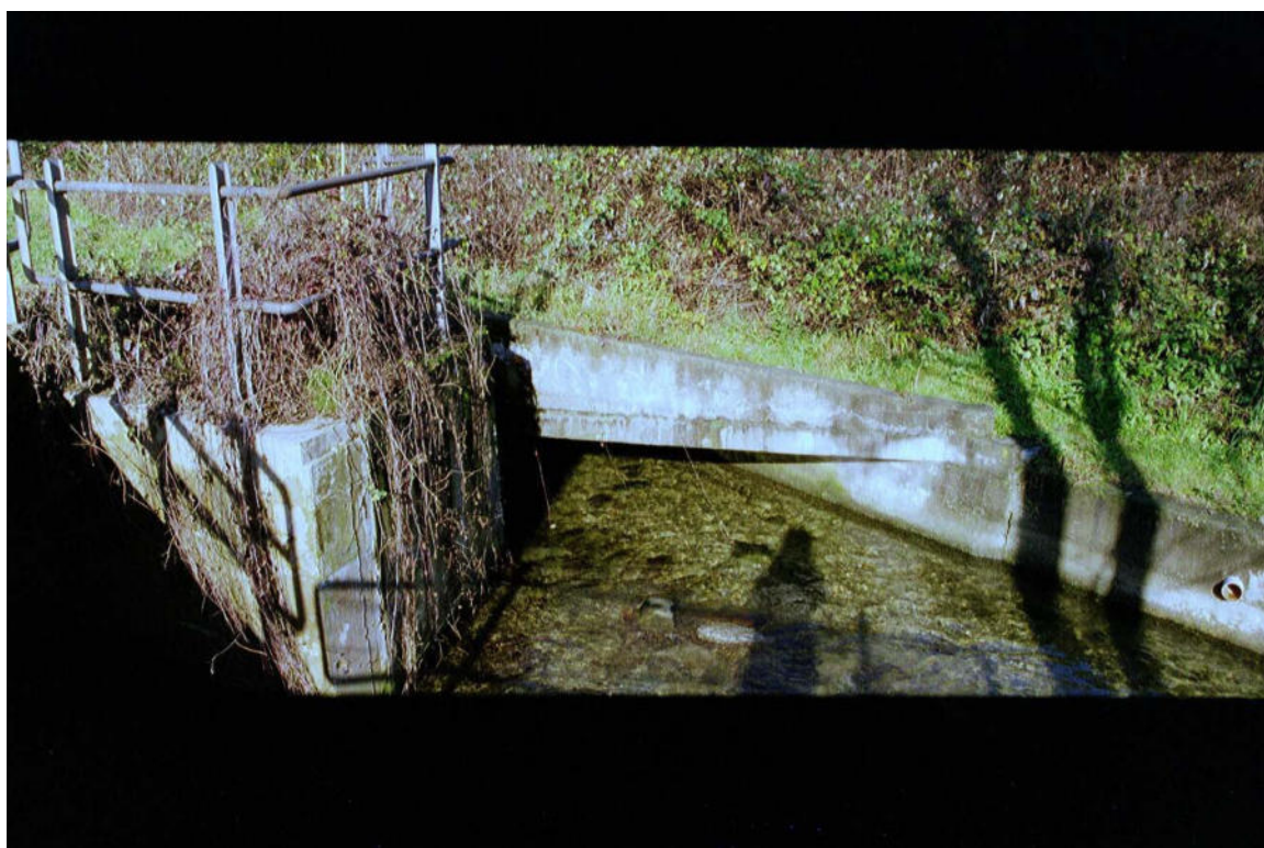
Foto 070 – Opera CANOAG061 . Ripresa da valle verso monte, Canale Comunale, affluente di sinistra del T. Pellice.
