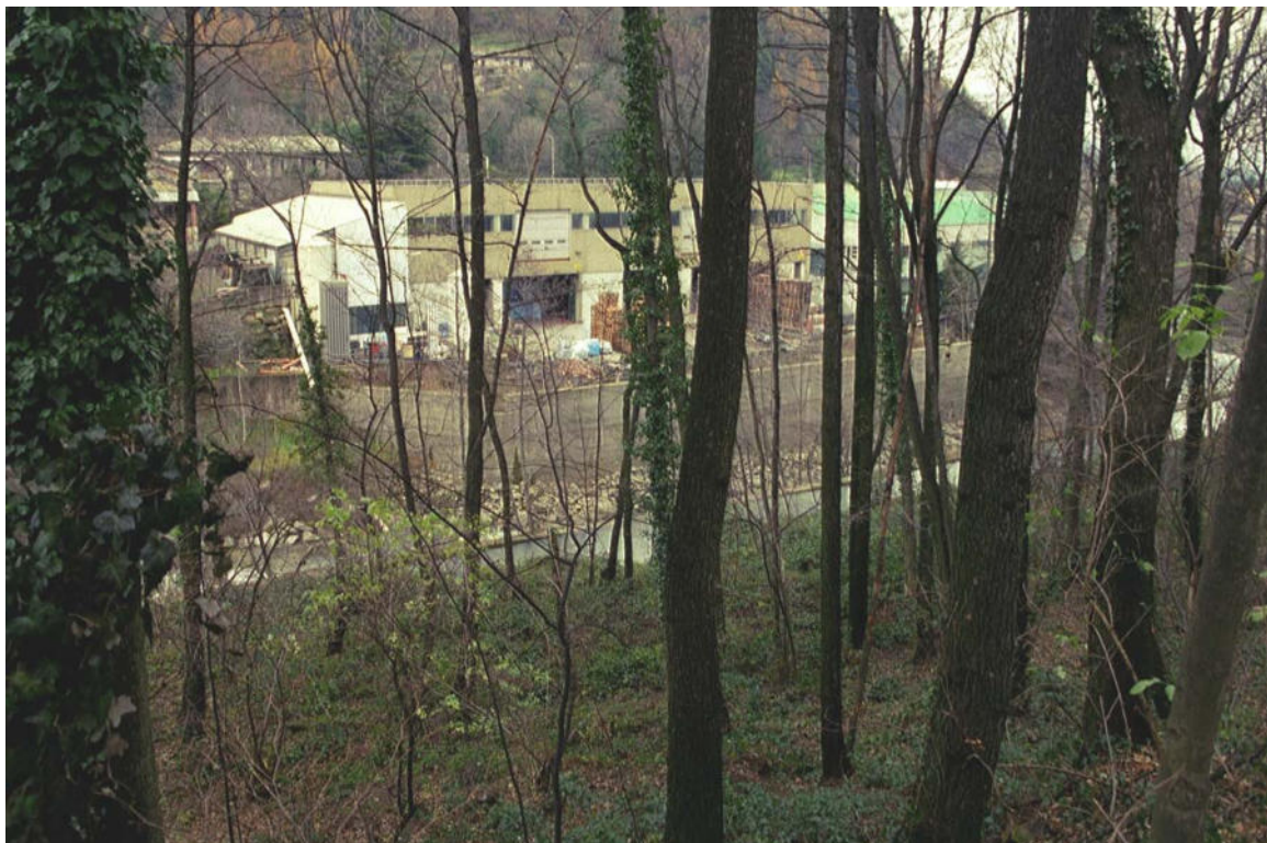
Foto 088 – Opera CANODS011 . Ripresa frontale, sponda sinistra, T. Luserna, affluente di destra del T. Pellice.
