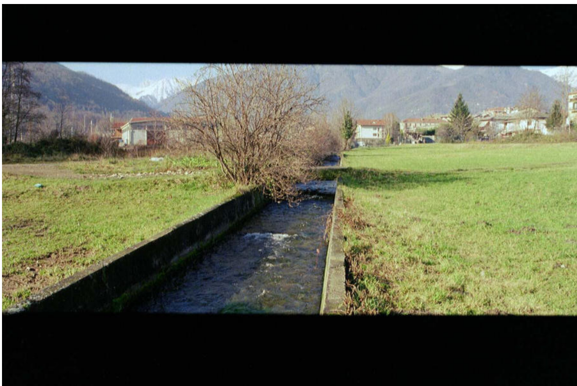
Foto 073 – Opera CANOAG064 . Ripresa da valle verso monte, Canale Comunale, affluente di sinistra del T. Pellice.
