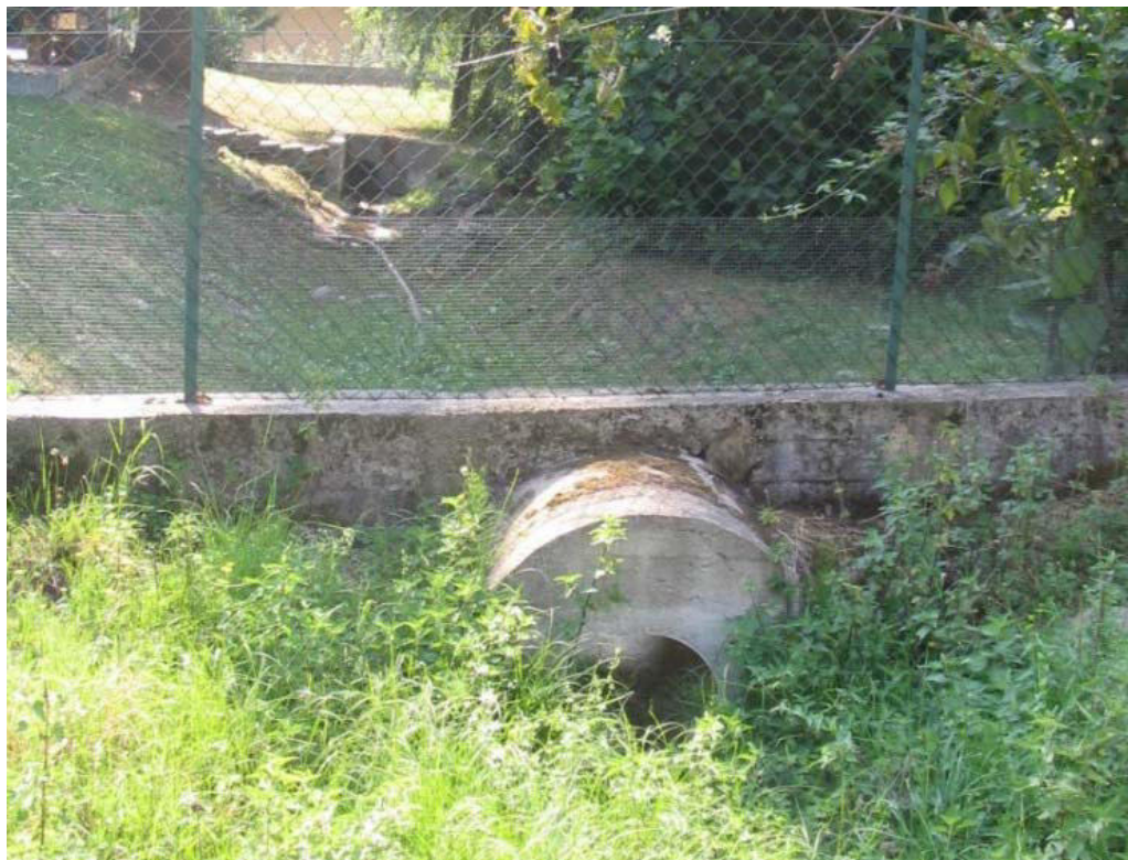
Foto 167 – Opera PENNCA031 . Ripresa frontale da monte (sullo sfondo l'imbocco del tratto intubato).
