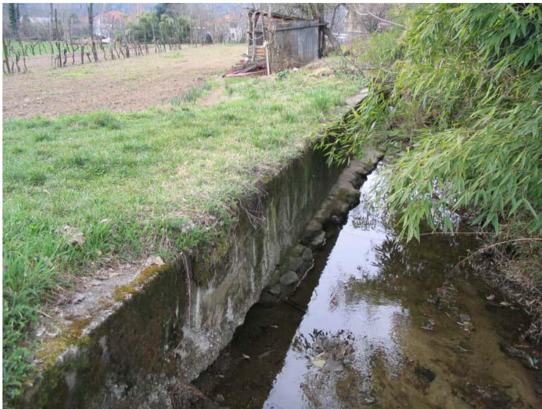
Foto 104B – Opera CANODS040 . Ripresa da monte, dall'attraversamento CANOAG038 (R.dei Boer, affluente di sinistra del T: Pellice).
