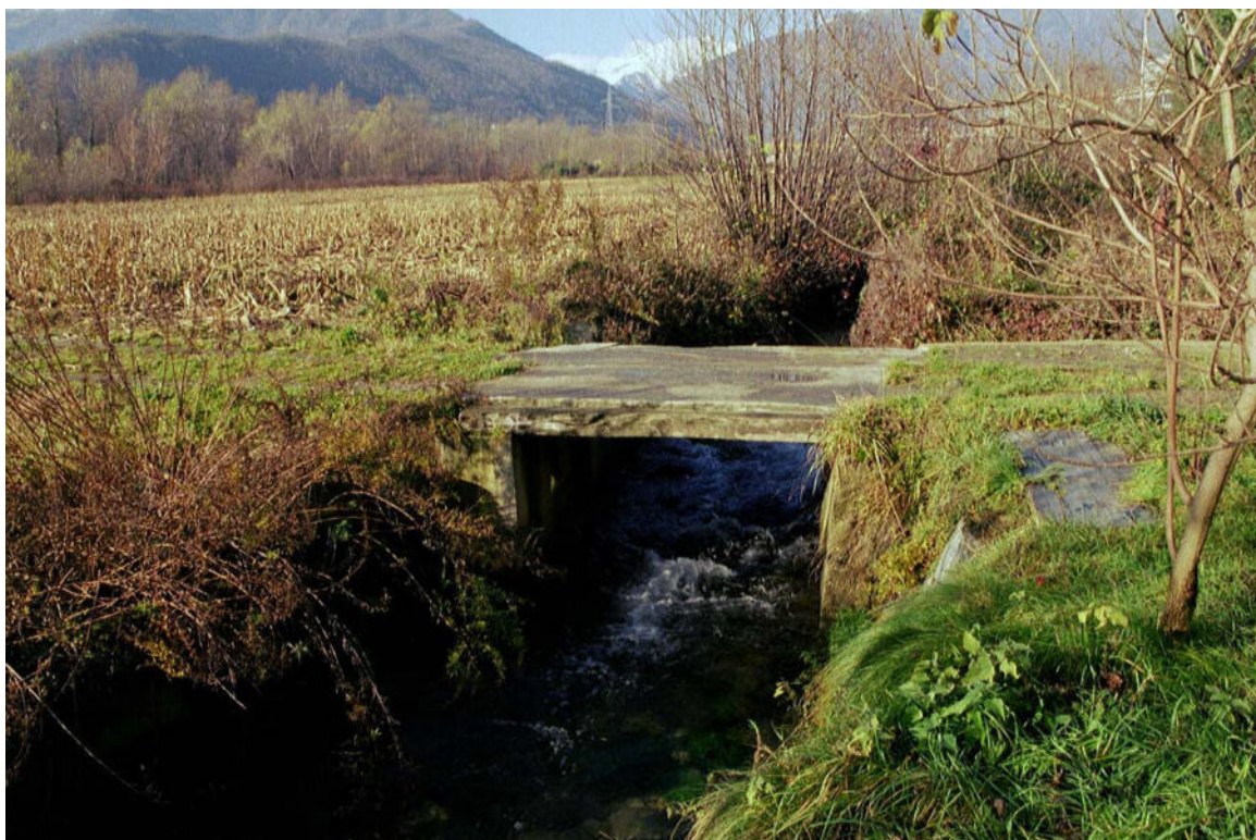
Foto 075 – Opera CANOAG066 . Ripresa da valle verso monte, Canale Comunale, affluente di sinistra del T. Pellice.
