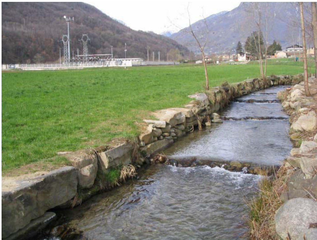
Foto 127A – Opera CANODS065 . Ripresa da valle, sponda sinistra Canale Comunale, affluente di sinistra del T. Pellice.
