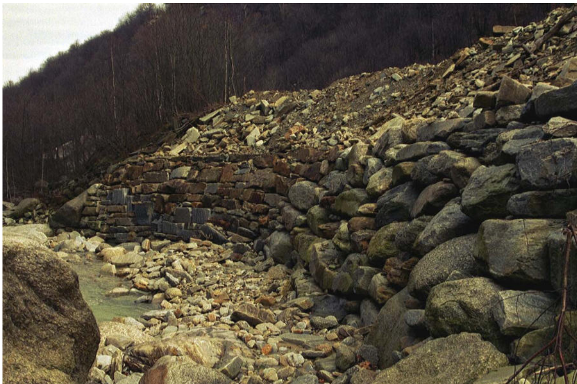
Foto 084 – Opera CANODS007 . Ripresa da monte verso valle, T. Luserna, affluente di destra del T. Pellice.
