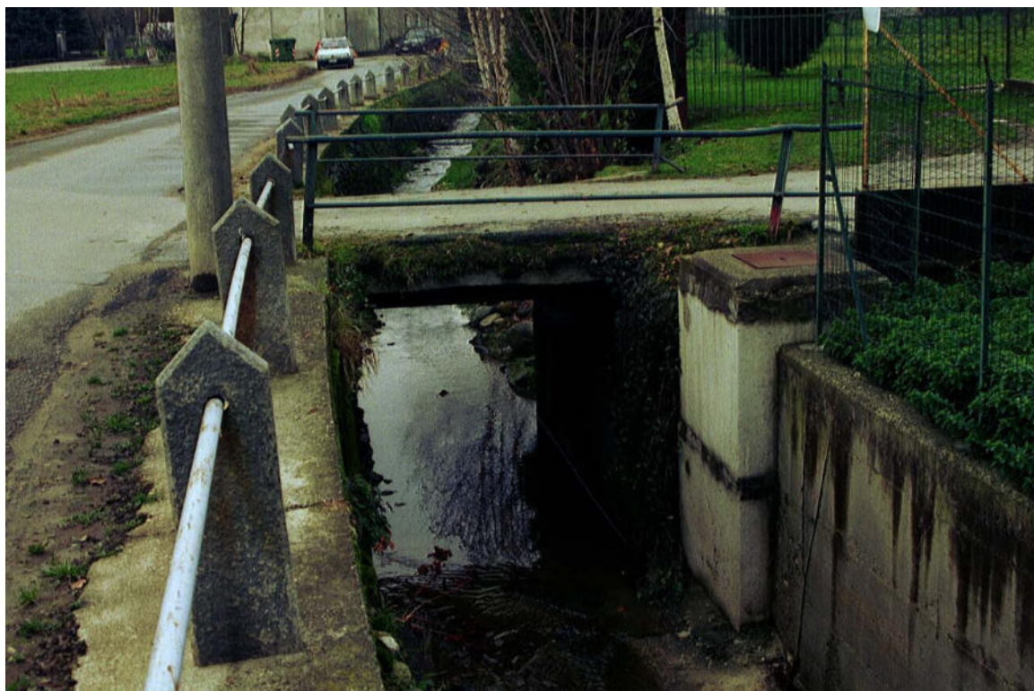
Foto 056 – Opera CANOAG048 . Ripresa da valle verso monte, T. Gambroero, affluente di sinistra del T. Pellice.
