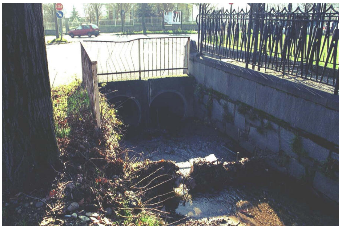
Foto 137 – Opere CANOBR006 e CANOBR007 . Ripresa da monte verso valle, Canale dei Mantelli, affluente di sinistra del T. Pellice.
