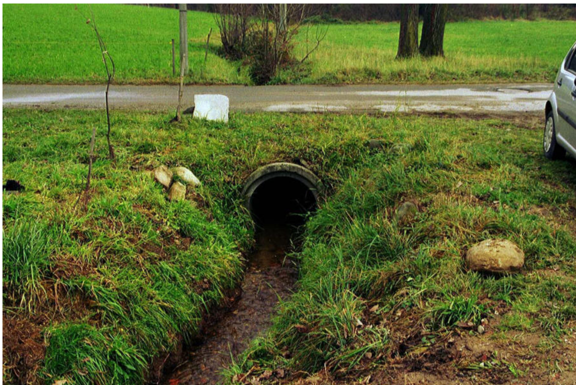
Foto 046 – Opera CANOAG038 . Ripresa da monte verso valle, rio degli Odin, affluente di destra del T. Gambrero.
