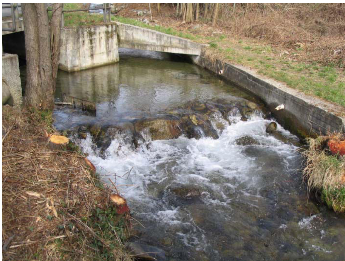
Foto 163 – Opera CANOSO020 . Ripresa da valle, sponda destra del Canale Comunale.
