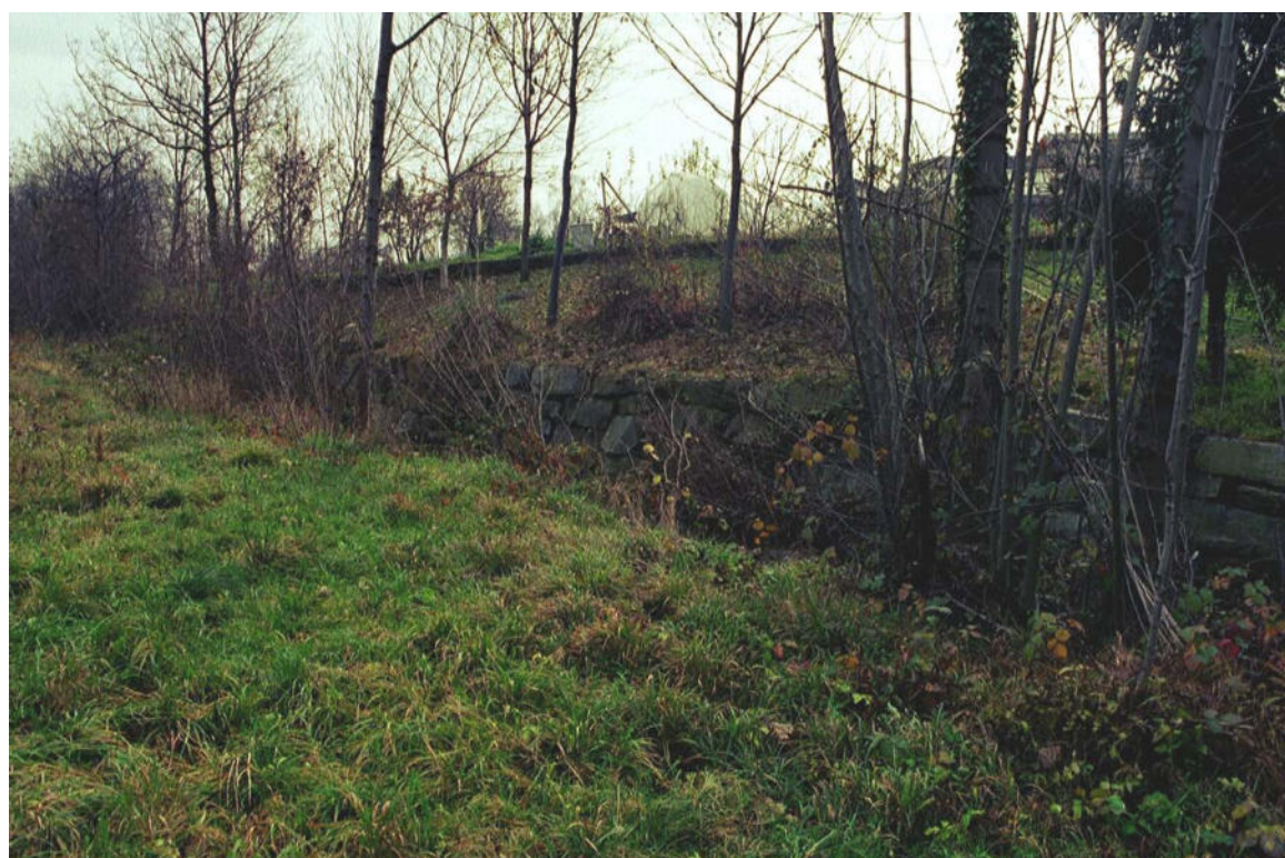
Foto 124 – Opera CANODS062 . Ripresa da monte verso valle, T. Gambrero, affluente di sinistra del T. Pellice.
