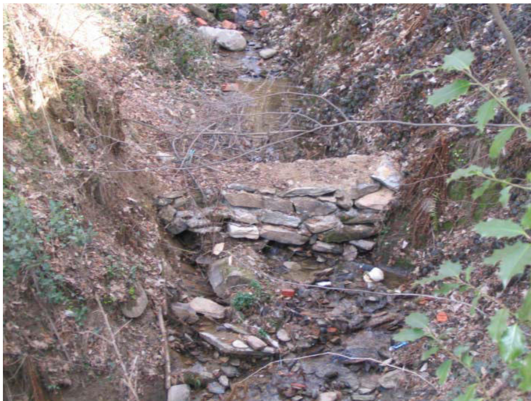
Foto 158 – Opera CANOBR004. Ripresa da valle, sponda sinistra del rio, affluente di sinistra del T. Pellice.
