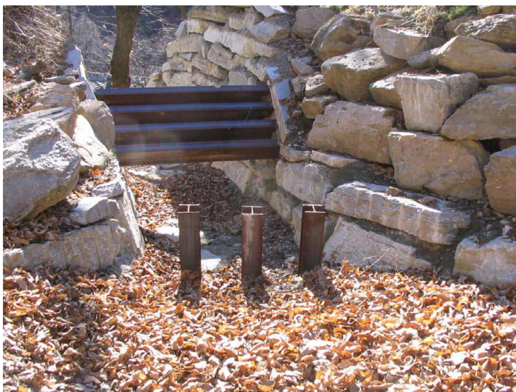
Foto 153 – Opera PENNSO022 . Ripresa da monte dall'alveo dell'impiuvio (C.se Fenoglia).
