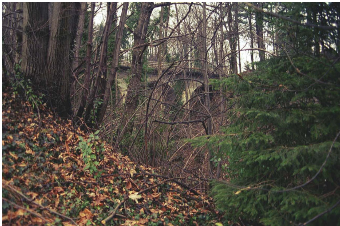
Foto 010 – Opera CANOPO010 . Ripresa da valle verso monte, Rio dei Baussan, affluente di sinistra del T. Pellice.
