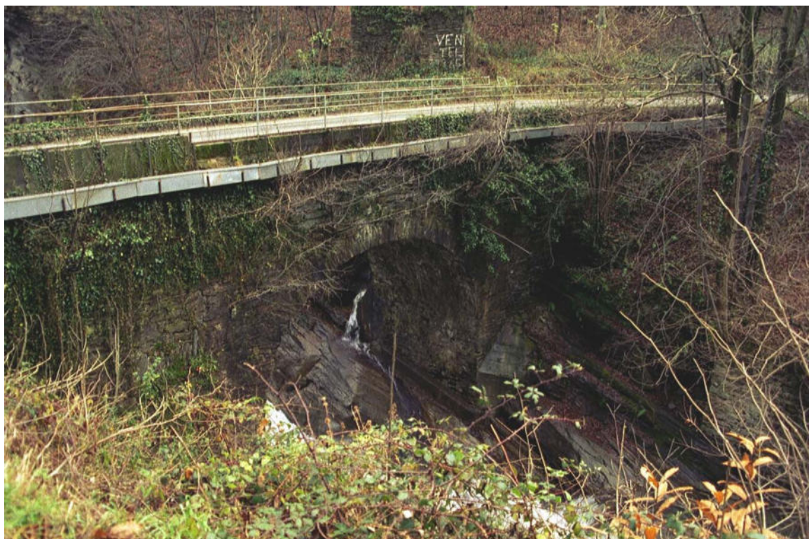
Foto 005 – Opera CANOPO005 . Ripresa da monte verso valle, T. Luserna, affluente di destra del T. Pellice.
