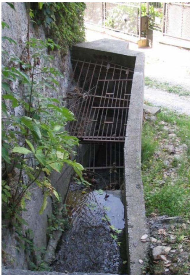
Foto 168 – Opera PENNCA032 . Ripresa frontale dell'imbocco a monte.
