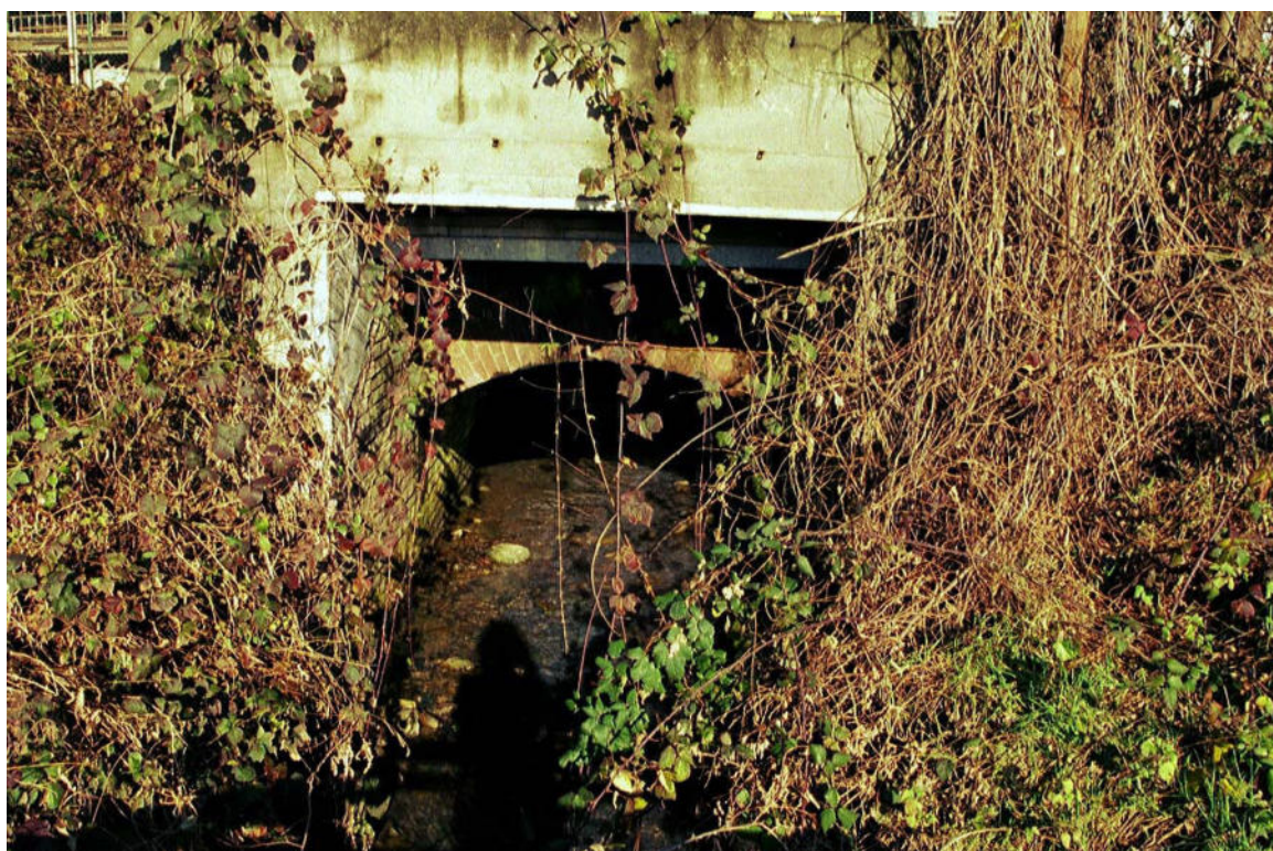
Foto 066 – Opera CANOAG019 . Ripresa da valle verso monte, Canale dei Mantelli, affluente di sinistra del T. Pellice.
