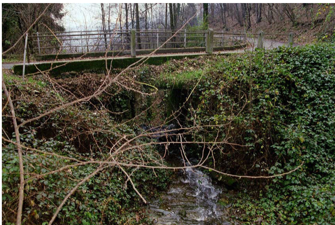
Foto 029 – Opera CANOAG021 . Ripresa da monte, sponda sinistra del R.dei Boer.
