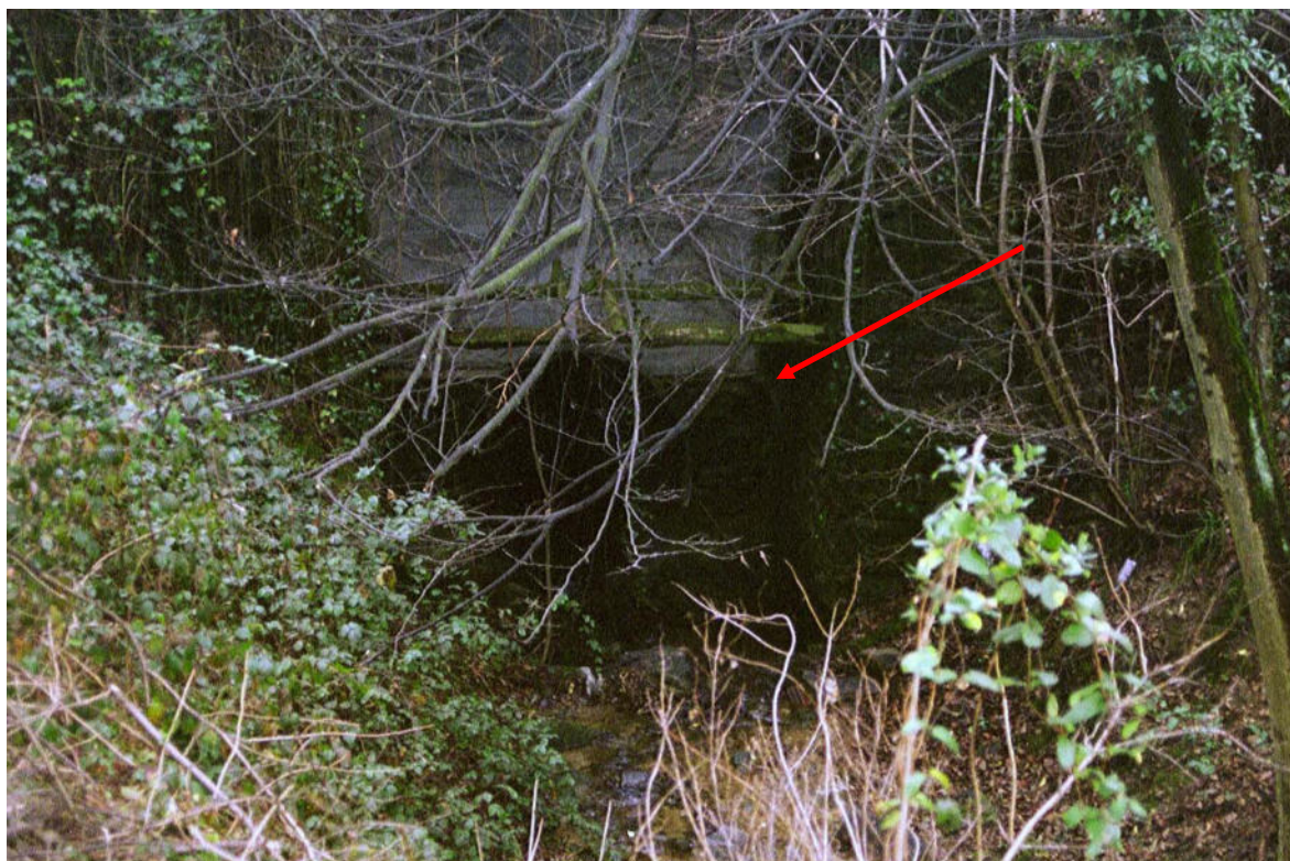
Foto 017 – Opera CANOAG007 . Ripresa da monte, sponda sinistra del Canale dei Mantelli.
