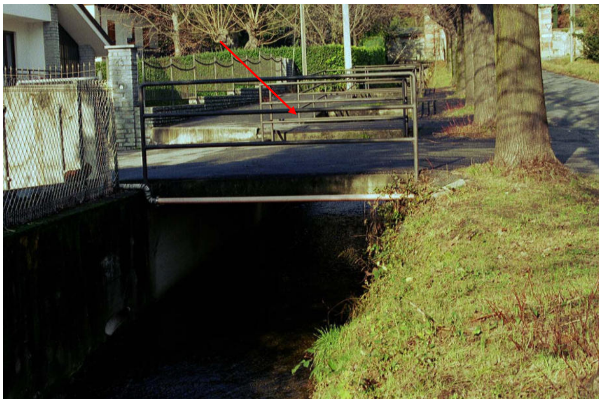
Foto 020 – Opera CANOAG012 (primo piano) e CANOAG013 (indicato dalla freccia). Ripresa frontale da valle, lungo il Canale dei Mantelli.
