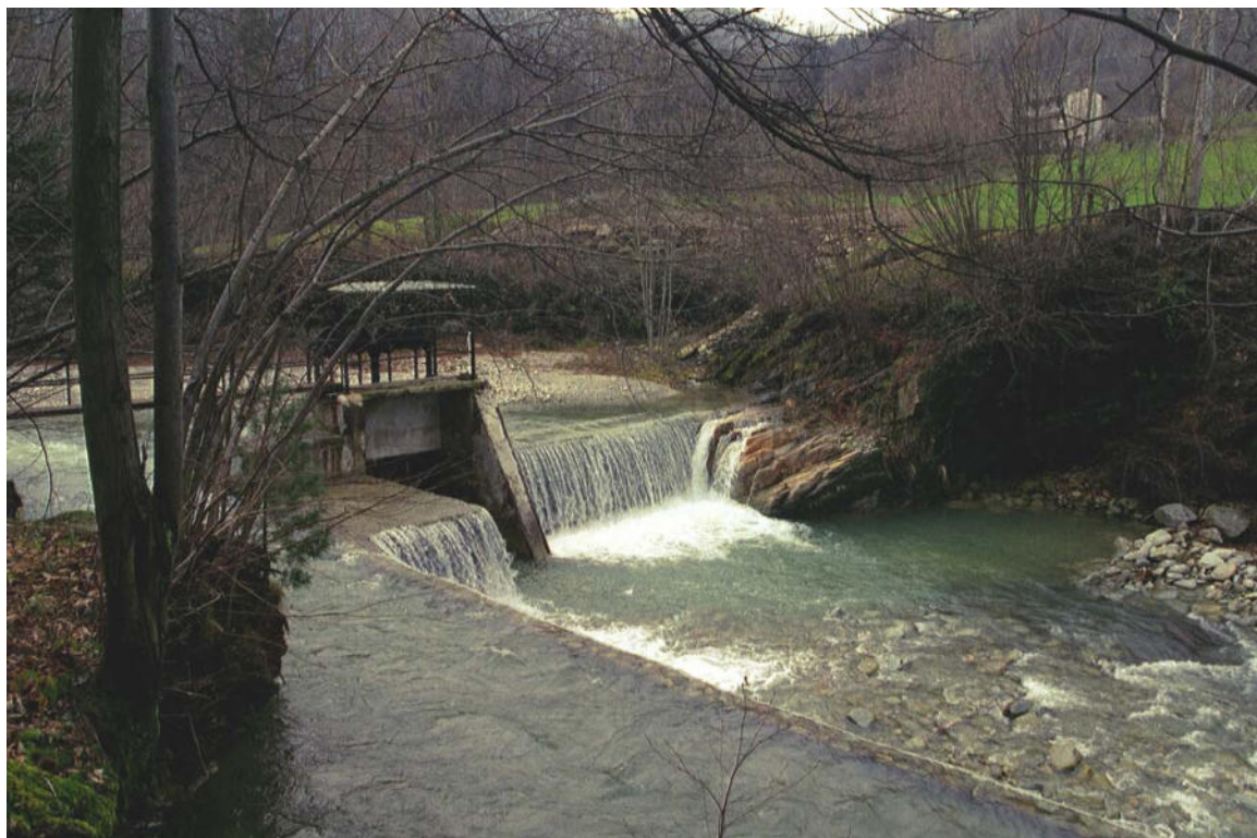
Foto 158 – Opera CANOSO005 . Ripresa da valle verso monte, T. Luserna, affluente di destra del T. Pellice.
