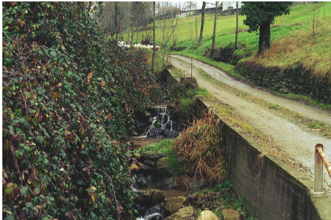
Foto 117 – Opere CANOSO017 e CANOSO018 . Ripresa da valle verso monte, Rio del Bric, affluente di sinistra del T. Gambrero.
