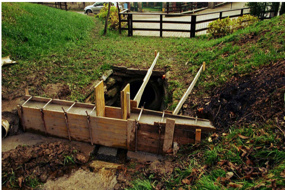
Foto 045 – Opera CANOAG037 . Ripresa da monte verso valle, rio degli Odin, affluente di destra del T. Gambrero.
