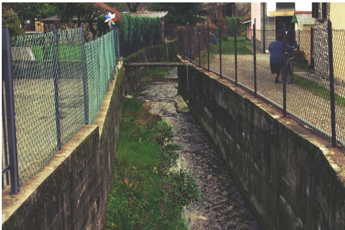
Foto 101 – Opere CANODS034 e CANODS035 . Ripresa da monte verso valle, Rio dei Boer, affluente di sinistra del T. Pellice.
