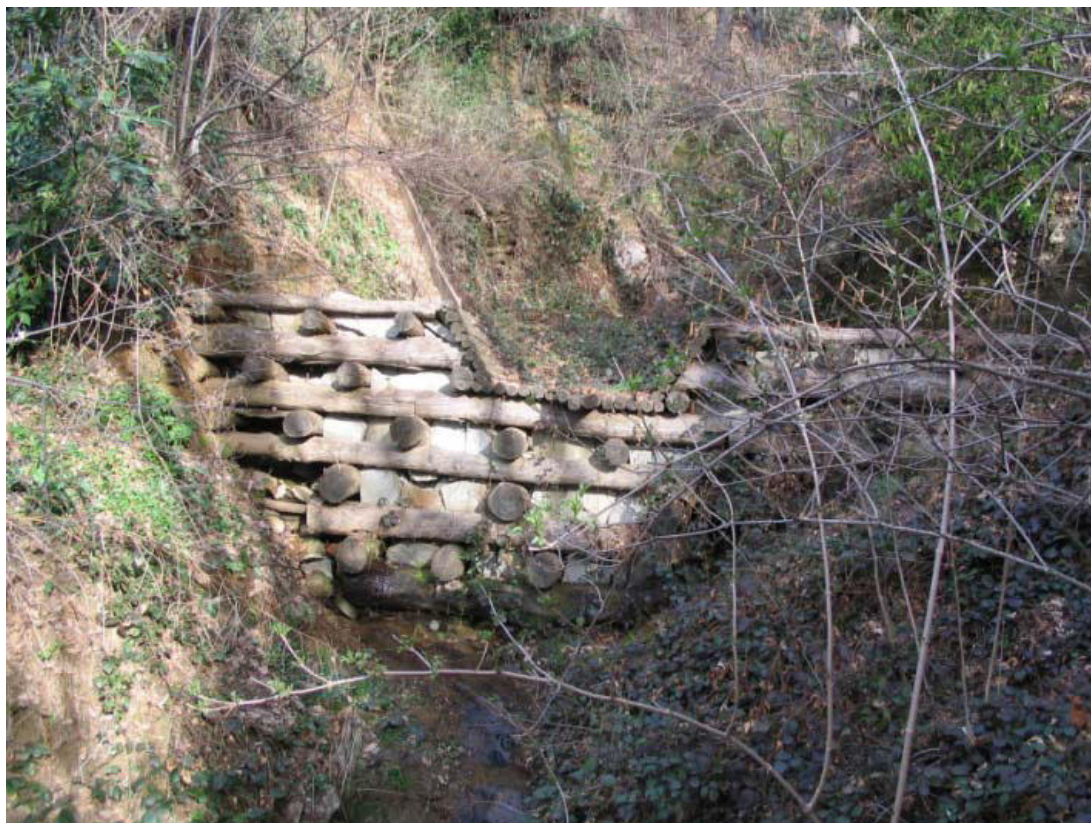
Foto 156 – Opera CANOBR002 . Ripresa da valle, sponda sinistra del rio, affluente di sinistra del T. Pellice.
