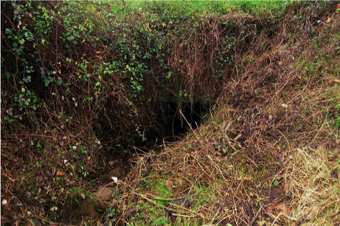
Foto 034 – Opera CANOAG026 . Ripresa da monte, sponda destra del R.dei Boer.
