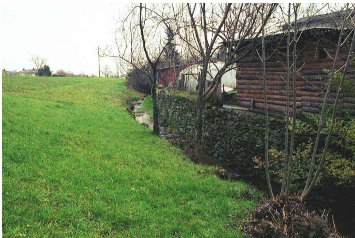
Foto 115 – Opera CANODS052 . Ripresa da monte verso valle, T. Gambrero, affluente di sinistra del T. Pellice.
