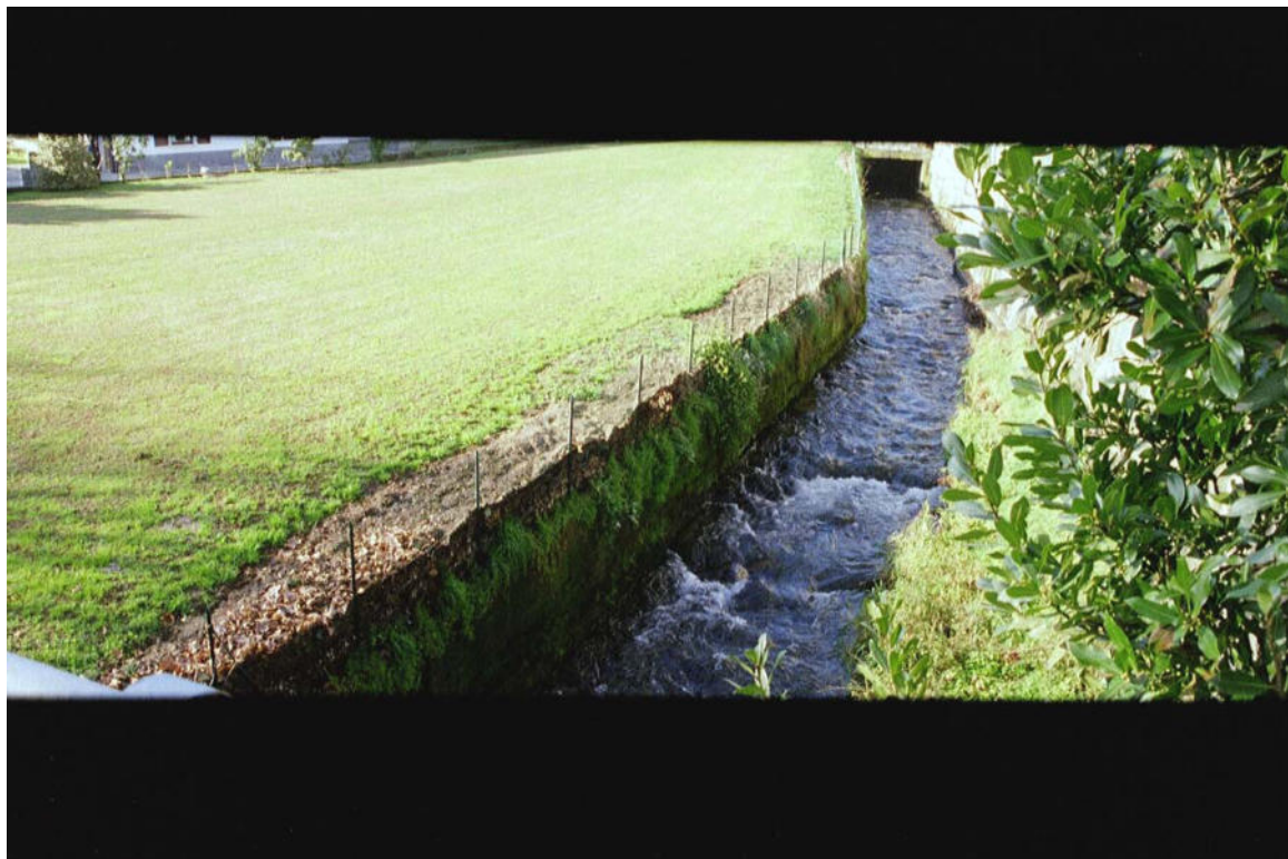
Foto 128 – Opera CANODS067 . Ripresa da valle verso monte, Canale Comunale, affluente di sinistra del T. Pellice.
