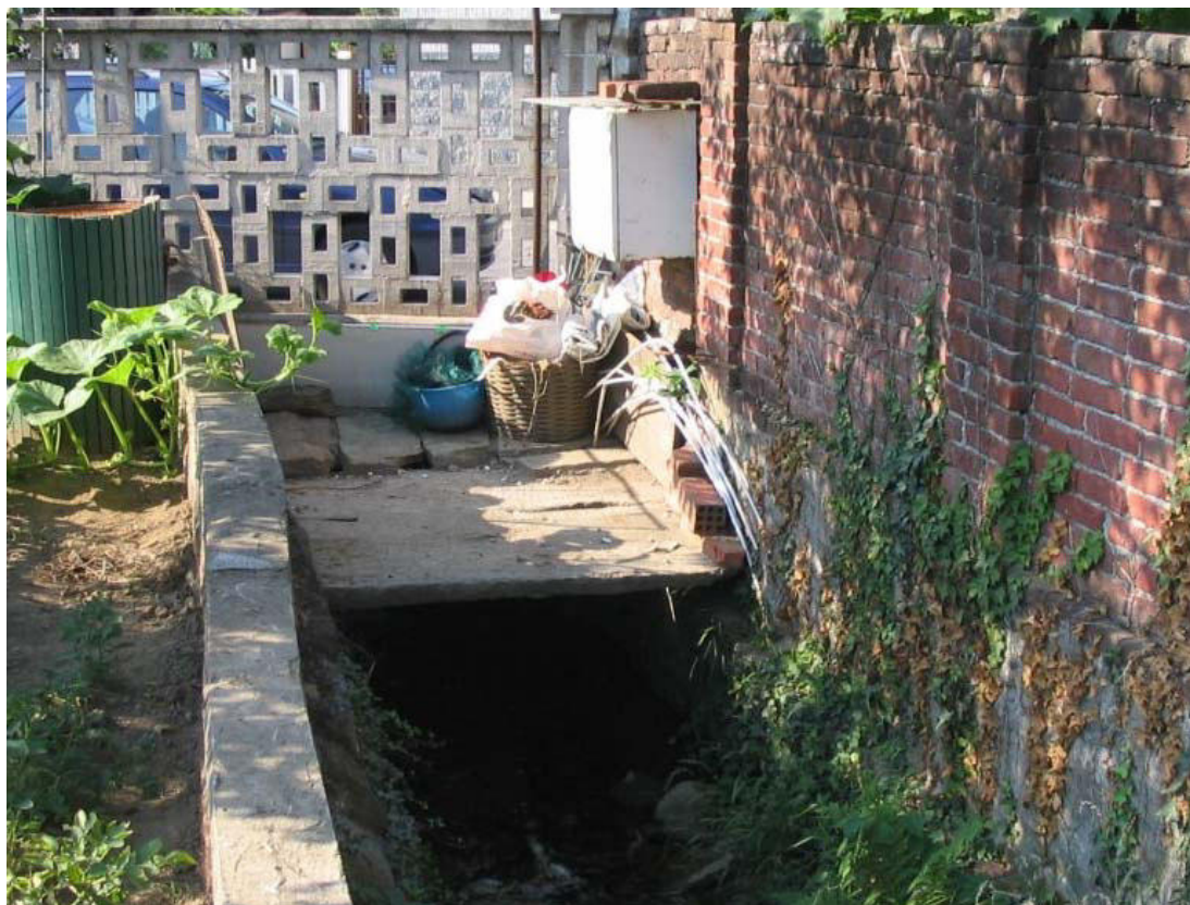
Foto 028 – Opera CANOAG020 . Ripresa da monte, sponda sinistra del Canale della Stazione (CANOCA011).
