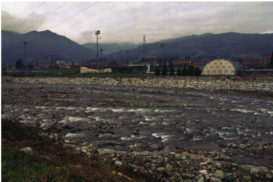
Foto 078 – Opera CANODS001 . Ripresa frontale, sponda sinistra, T. Pellice.
