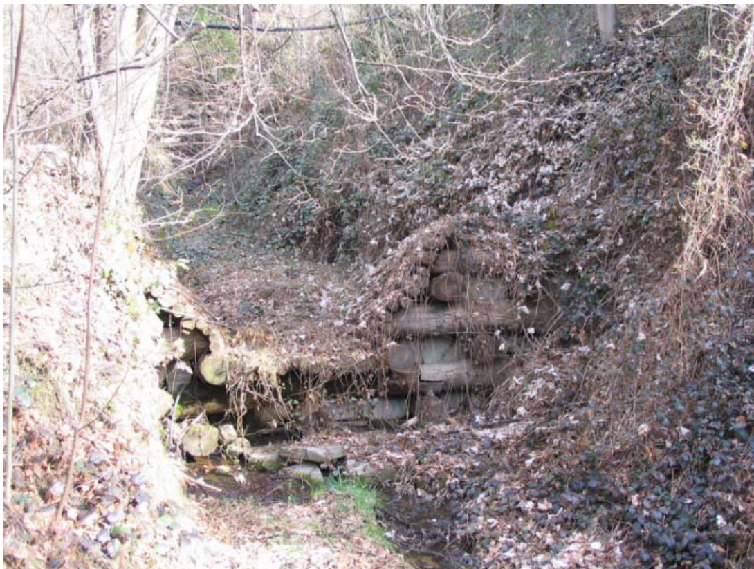
Foto 157 – Opera CANOBR003. Ripresa da valle, sponda destra del rio, affluente di sinistra del T. Pellice.
