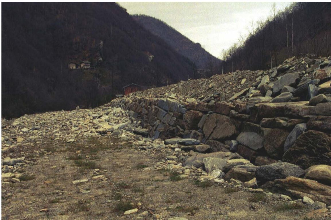
Foto 086 – Opera CANODS009 . Ripresa da monte verso valle, T. Luserna, affluente di destra del T. Pellice.
