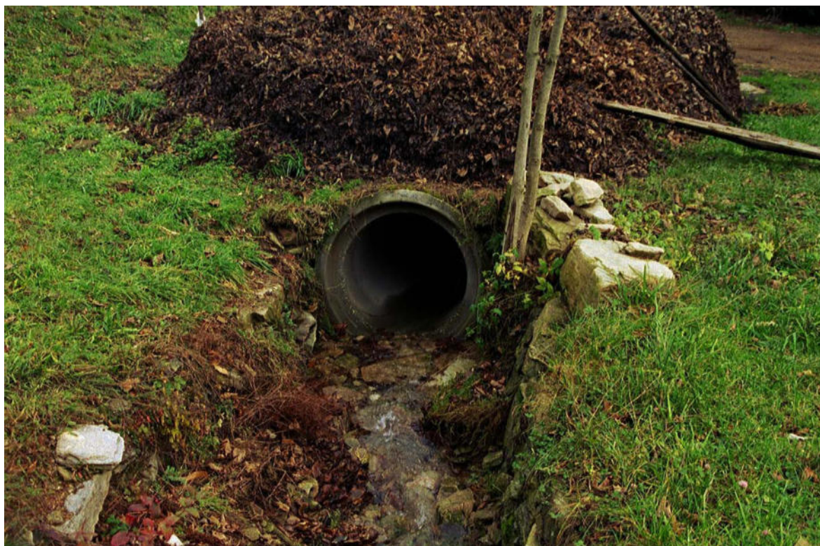
Foto 011 – Opera CANOAG001 . Ripresa da monte, sponda destra del R.Fenoglia I.
