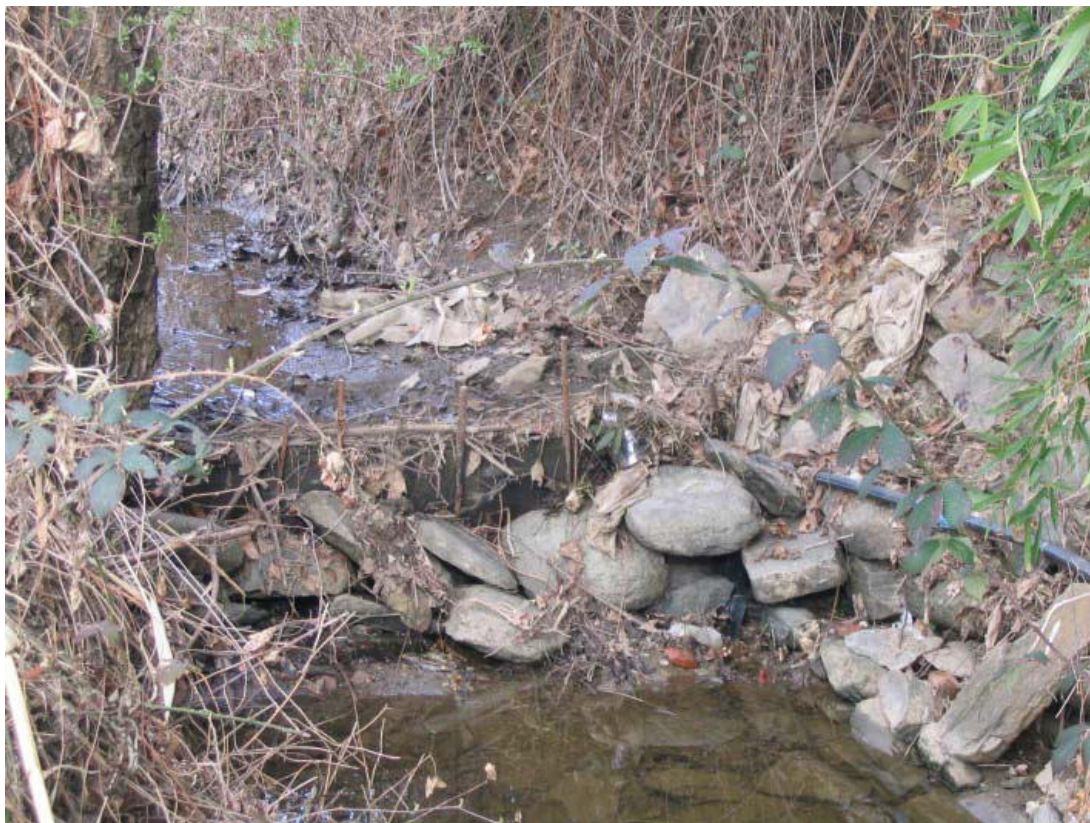
Foto 159 – Opera CANOBR008 . Ripresa frontale dall'attraversamento CANOAG020 (Canale della Stazione).
