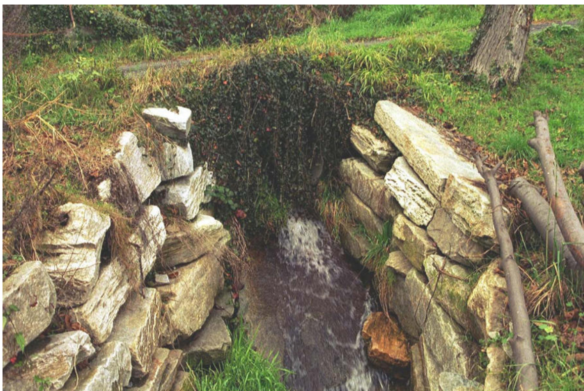
Foto 134 – Opera CANOCA004 . Ripresa da valle verso monte, Rio Cacciaira, affluente di sinistra del T. Luserna.
