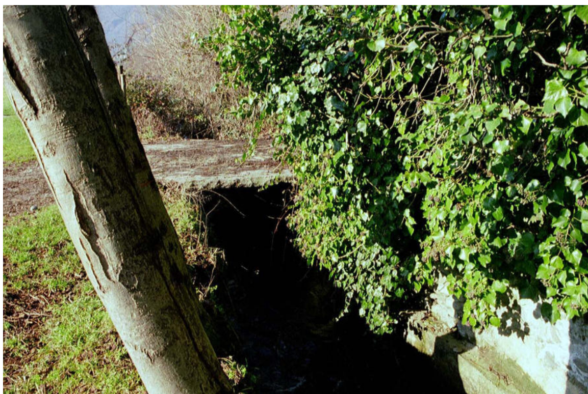
Foto 065 – Opera CANOAG057 . Ripresa da valle verso monte, Canale Comunale, affluente di sinistra del T. Pellice.
