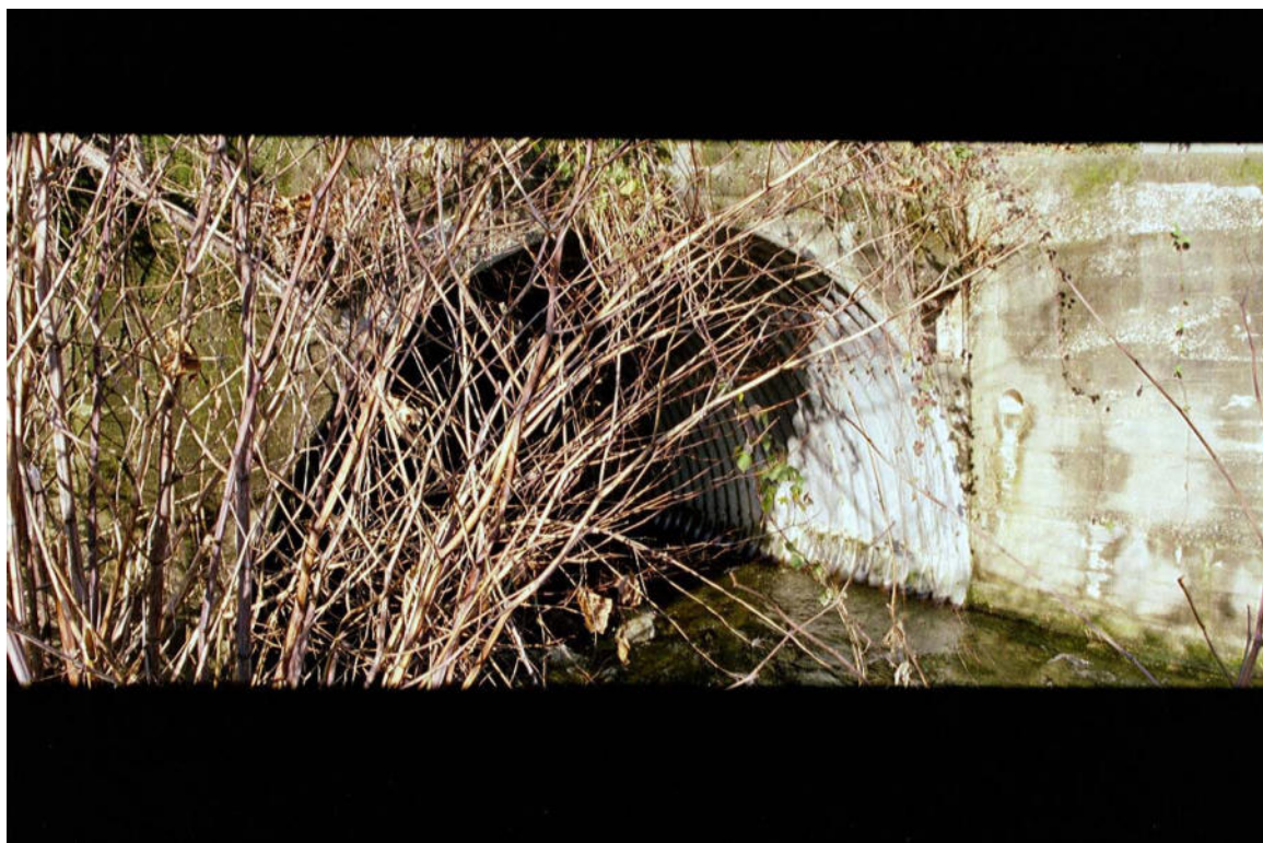
Foto 071 – Opera CANOAG062 . Ripresa da valle verso monte, Canale Comunale, affluente di sinistra del T. Pellice.
