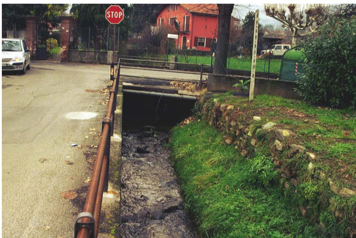
Foto 040 – Opere CANODS032 e CANODS033 . Ripresa da valle verso monte, Rio dei Boer, affluente di sinistra del T. Pellice.
