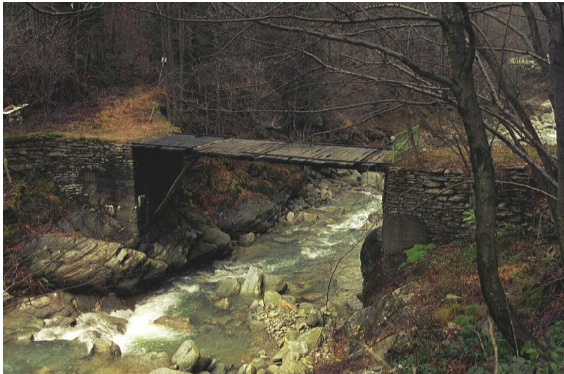
Foto 002 – Opera CANOPO002 . Ripresa da monte verso valle, T. Luserna, affluente di destra del T. Pellice
