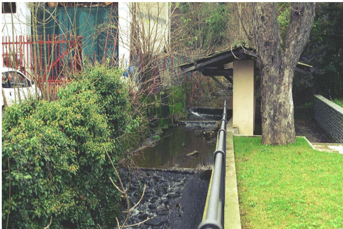
Foto 112 – Opere CANOBR010 , CANOBR011 e CANOBR012 . Ripresa da valle verso monte, T. Gambrero, affluente di sinistra del T. Pellice.
