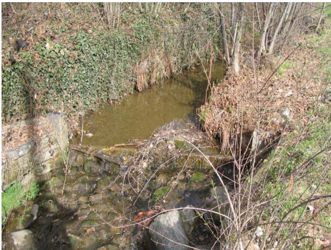
Foto 160 – Opera CANOAG009 . Ripresa da valle, sponda sinistra del T. Gambrero.
