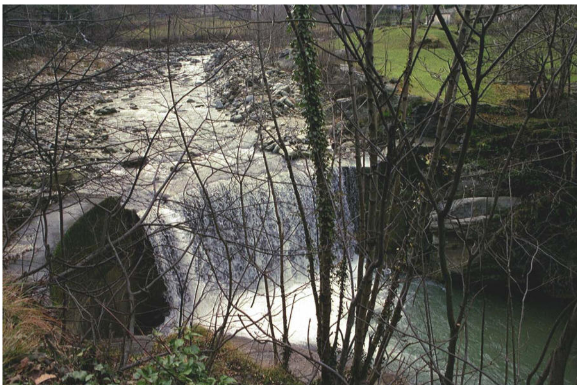
Foto 157 – Opera CANOSO004 . Ripresa da valle verso monte, T. Luserna, affluente di destra del T. Pellice.
