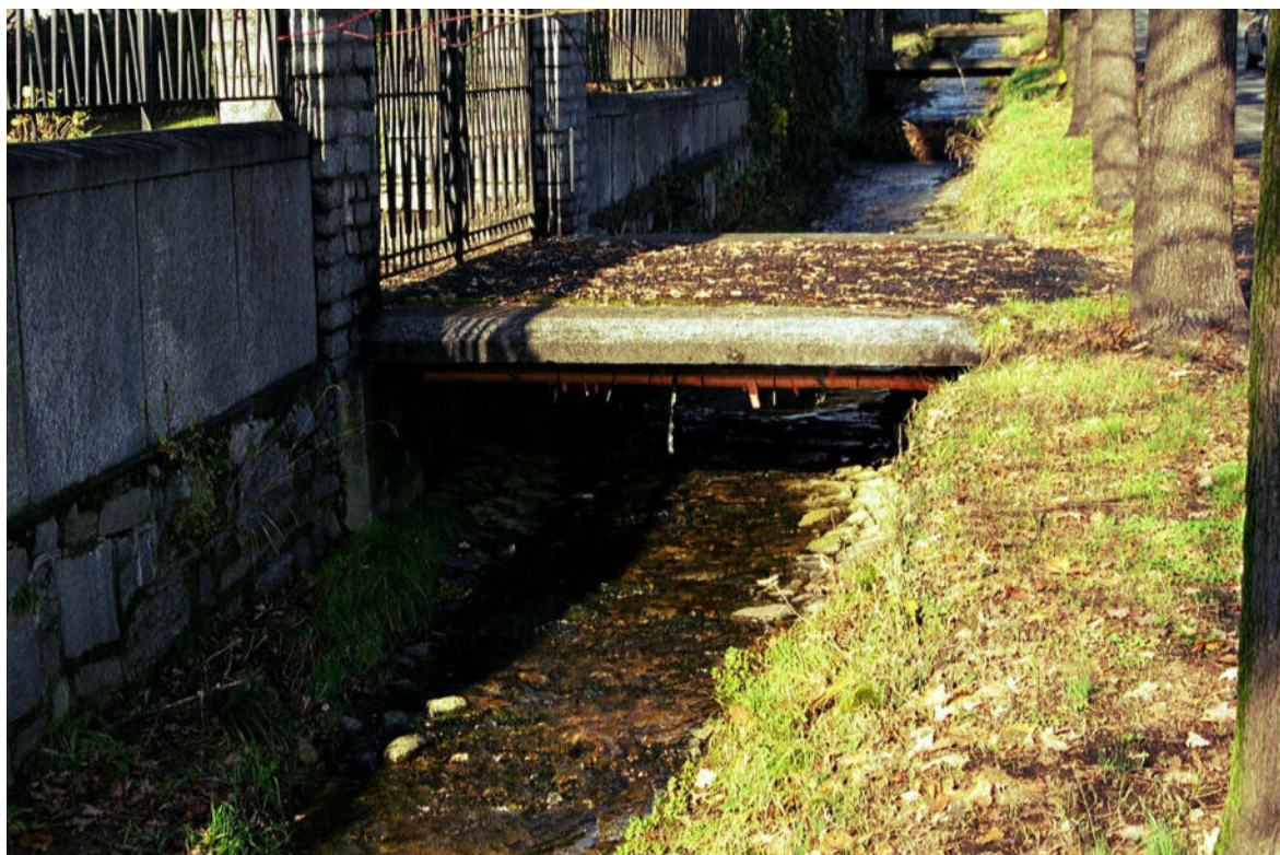
Foto 025 – Opera CANOAG018 . Ripresa da valle, sponda sinistra del Canale dei Mantelli.
