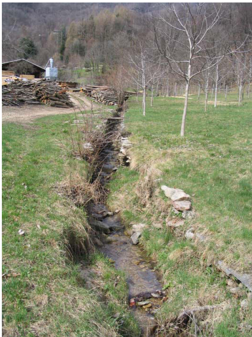
Foto 151 – Opera CANOCA027 . Ripresa da valle, sponda destra del R. Fenoglia II, affluente di sinistra del T. Luserna.
