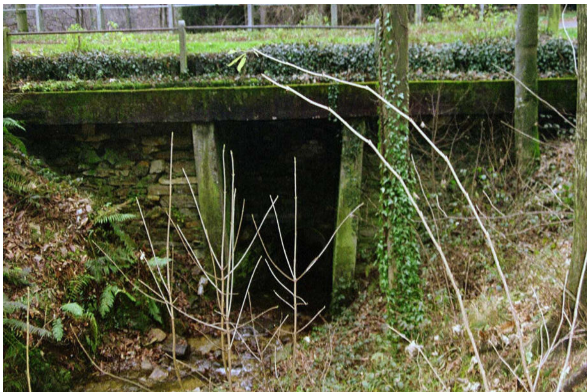
Foto 030 – Opera CANOAG022 . Ripresa da monte, sponda destra del R.dei Boer.
