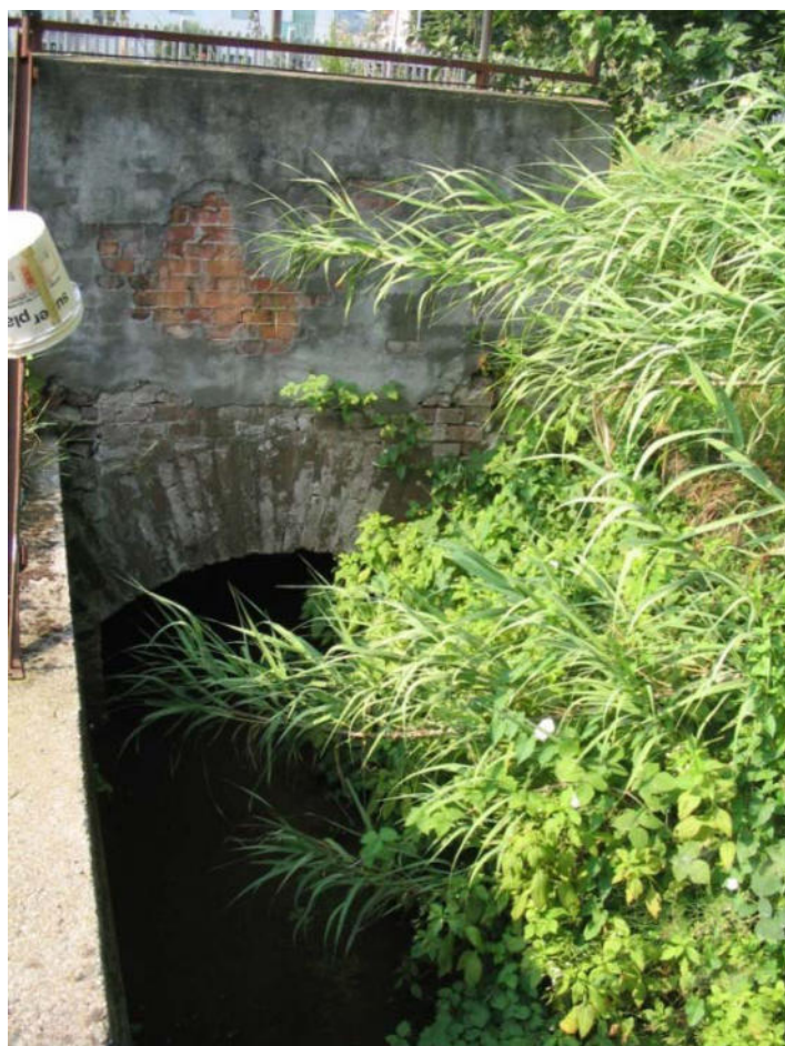
Foto 140 – Opera CANOCA011 . Ripresa frontale dell'imbocco a monte a fianco della ferrovia.
