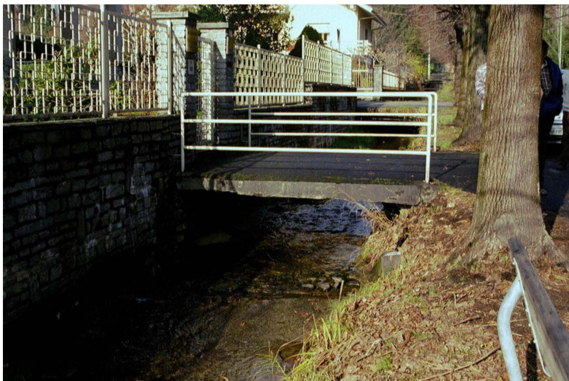
Foto 022 – Opera CANOAG015 . Ripresa da valle, sponda sinistra del Canale dei Mantelli.
