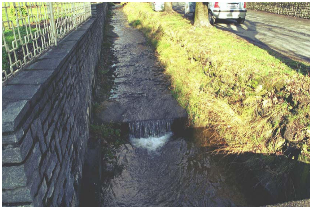
Foto 162 – Opera CANOSO010 . Ripresa da valle verso monte, Canale dei Mantelli, affluente di sinistra del T. Pellice.
