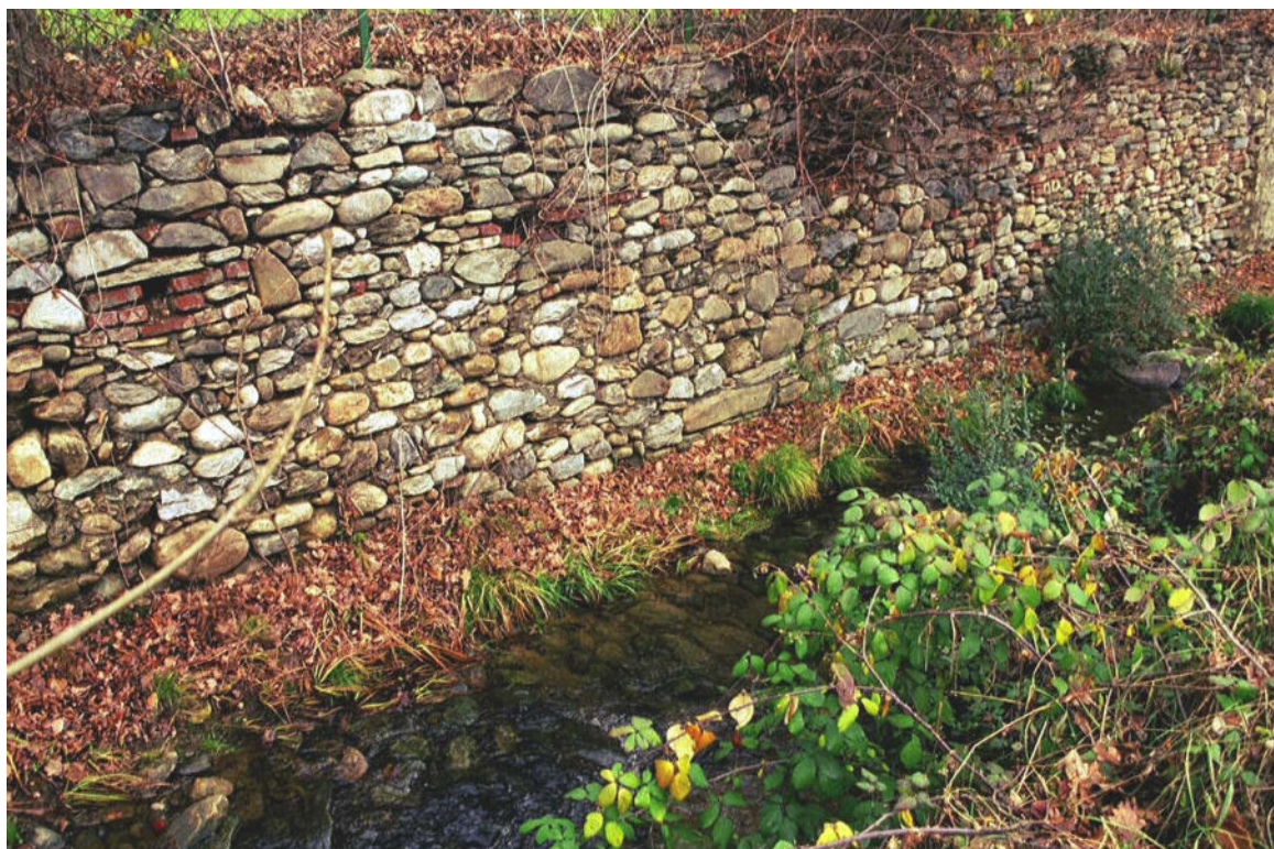
Foto 147 – Opera CANOCA022 . Ripresa da monte verso valle, T. Gambrero, affluente di sinistra del T. Pellice.
