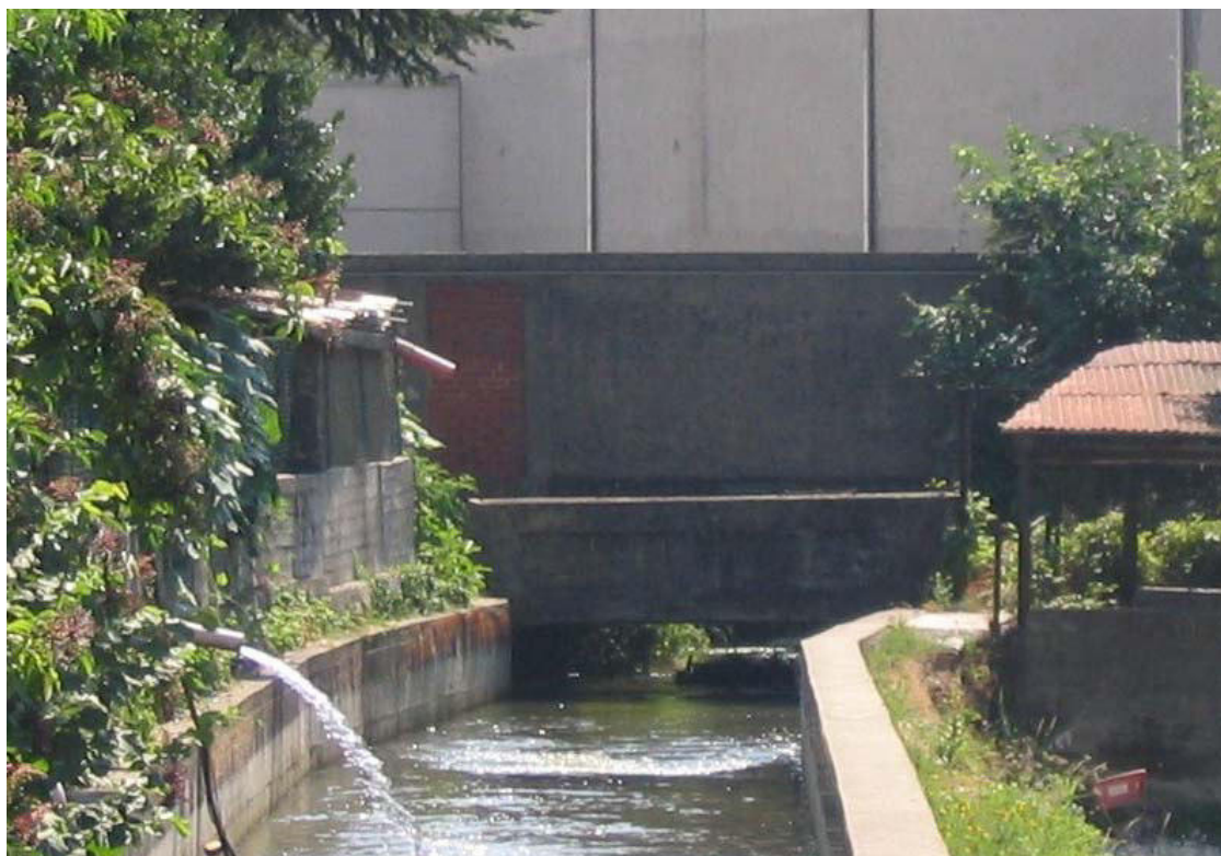
Foto 170 – Opera PENNCA034 . Ripresa frontale dell'imbocco a monte.
