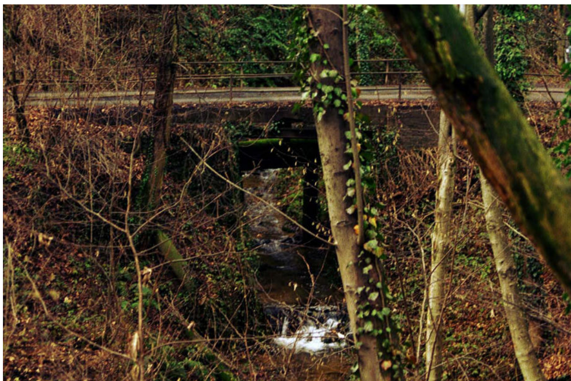
Foto 031 – Opera CANOAG023 . Ripresa da valle, sponda destra del R.dei Boer.
