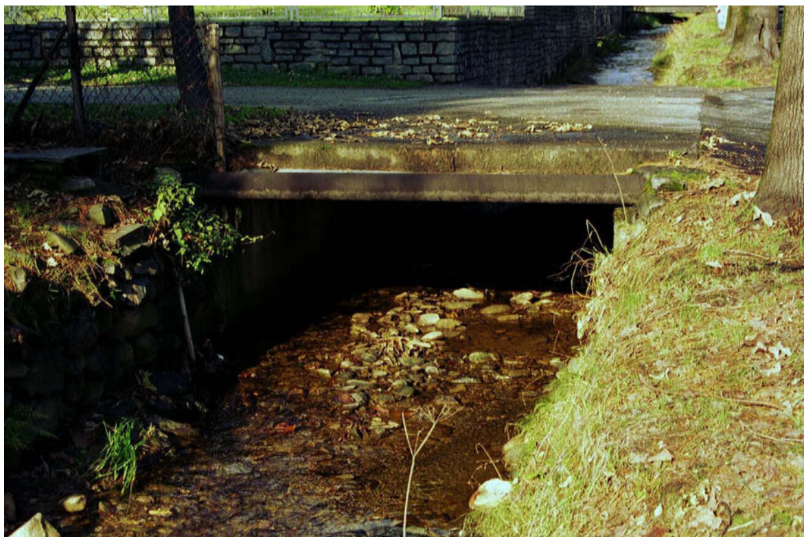
Foto 023 – Opera CANOAG016 . Ripresa da valle, sponda sinistra del Canale dei Mantelli.
