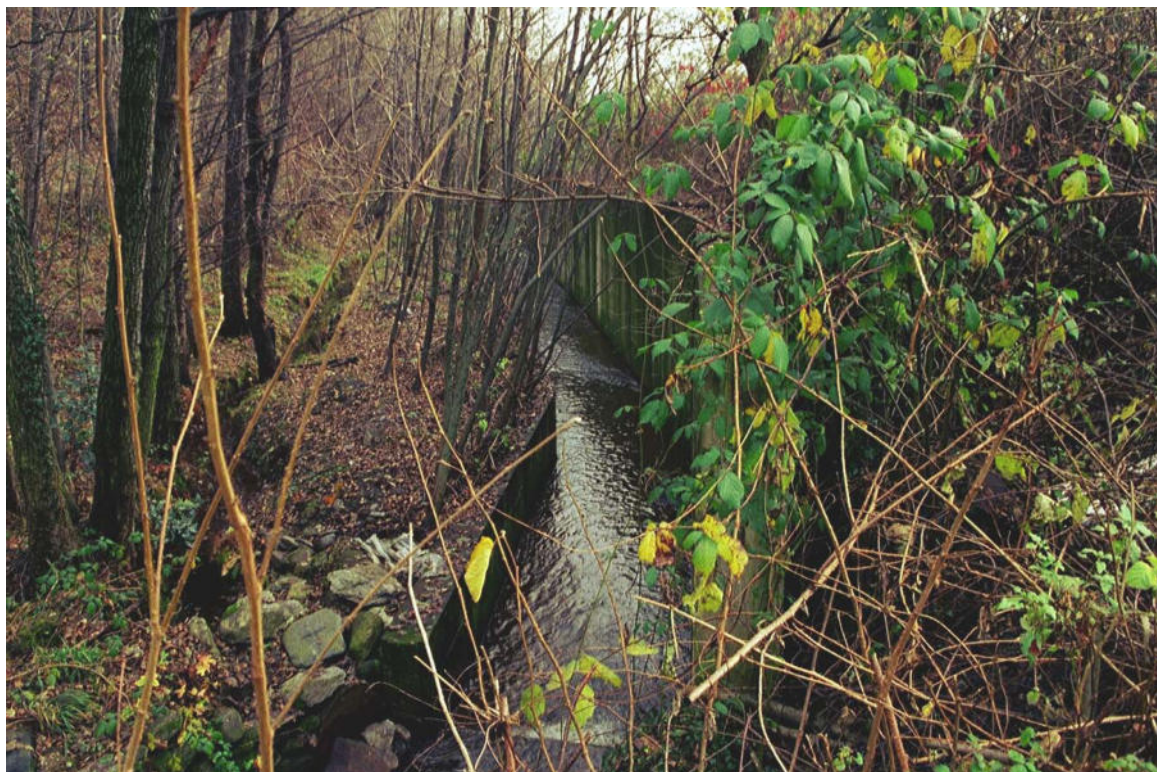
Foto 149 – Opera CANOCA025 . Ripresa da monte verso valle, T. Gambrero, affluente di sinistra del T. Pellice.
