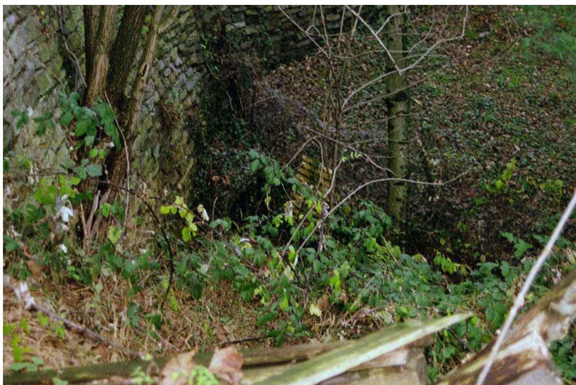
Foto 033 – Opera CANOAG025 . Ripresa da valle, sponda destra del R.dei Boer.
