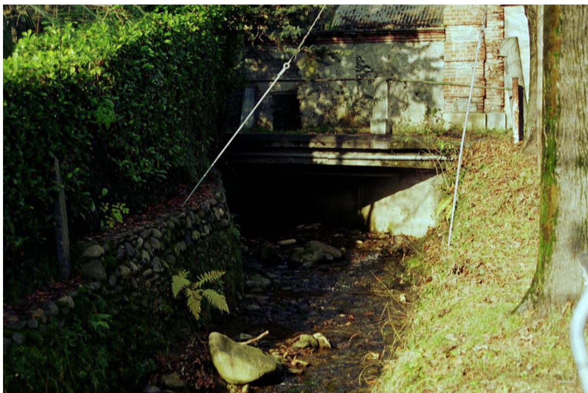
Foto 018 – Opera CANOAG009 . Ripresa da valle, sponda sinistra del Canale dei Mantelli.
