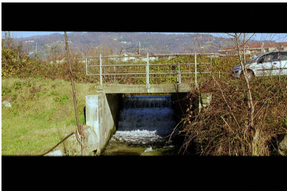
Foto 068 – Opera CANOAG059 . Ripresa da valle verso monte, Canale Comunale, affluente di sinistra del T. Pellice.
