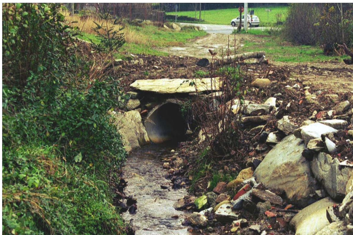
Foto 146 – Opera CANOCA019 . Ripresa da monte verso valle, T. Gambrero, affluente di sinistra del T. Pellice.
