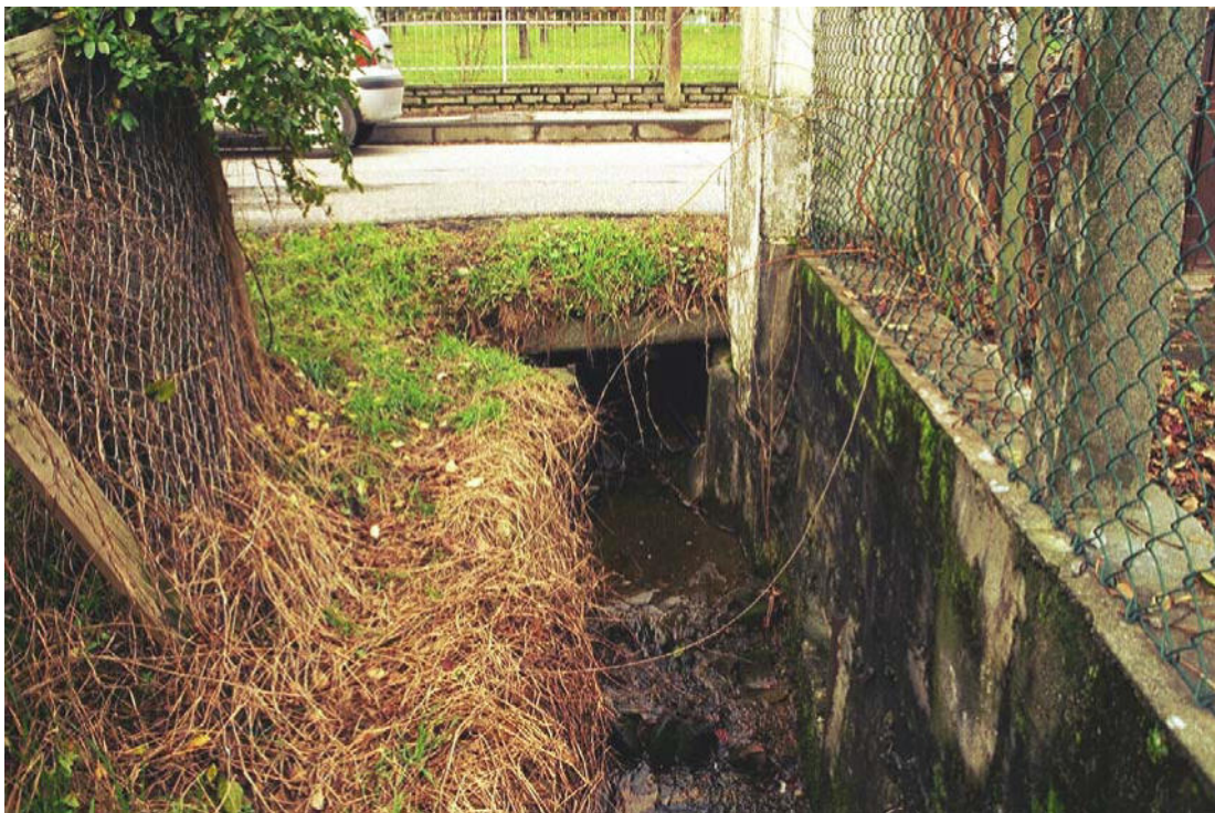
Foto 138 – Opera CANOCA009 . Ripresa da valle verso monte, Canale della Stazione, affluente di sinistra del T. Pellice.
