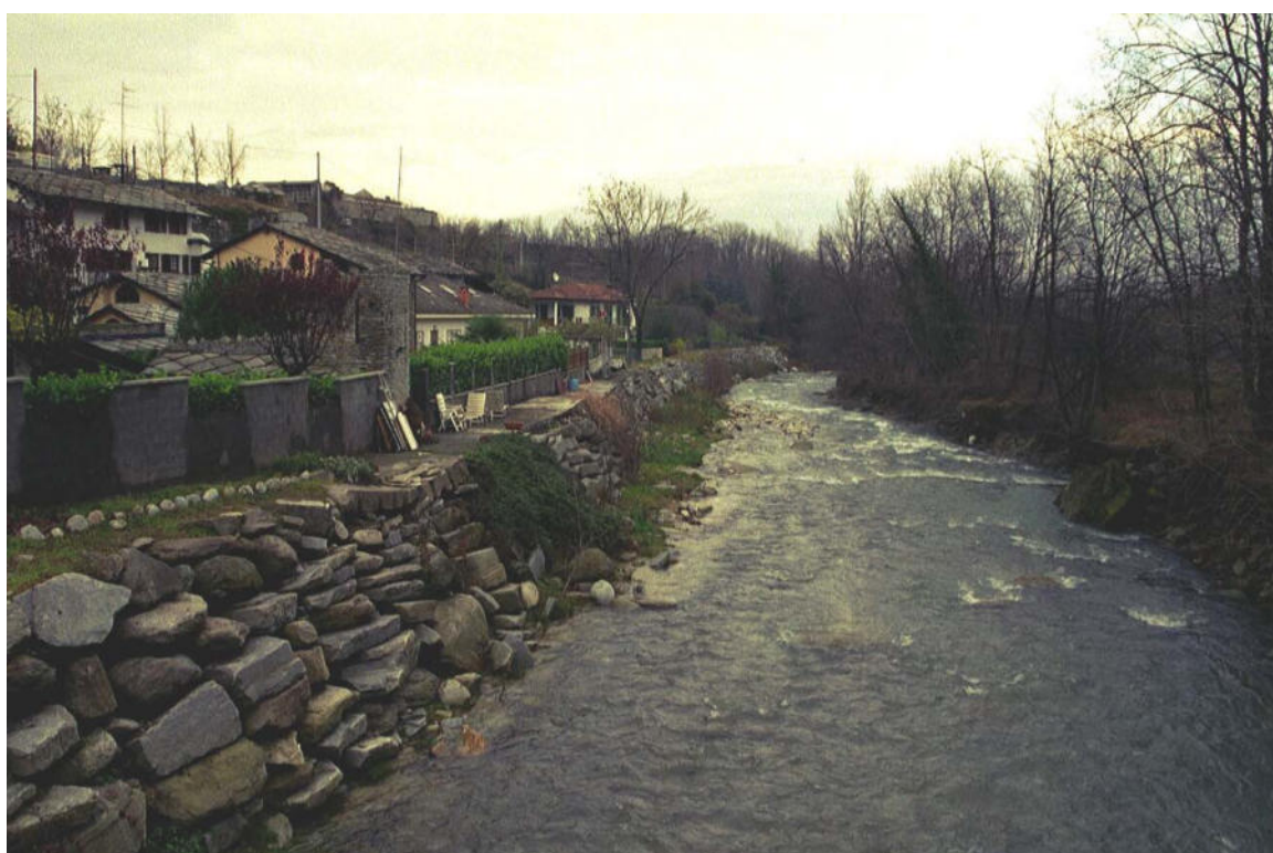
Foto 089 – Opera CANODS012 . Ripresa da monte verso valle, T. Luserna, affluente di destra del T. Pellice.
