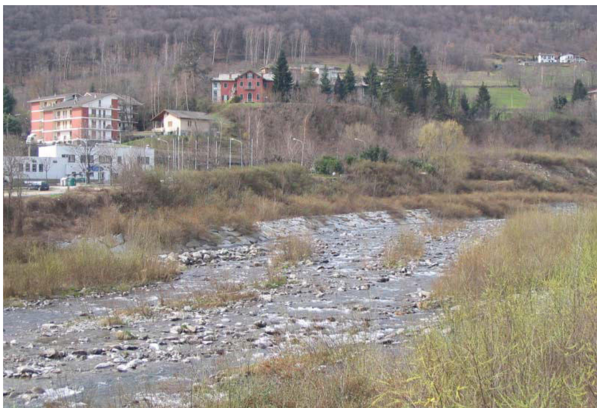
Foto 083 – Opera CANODS006 . Ripresa frontale, sponda destra, T. Pellice.
