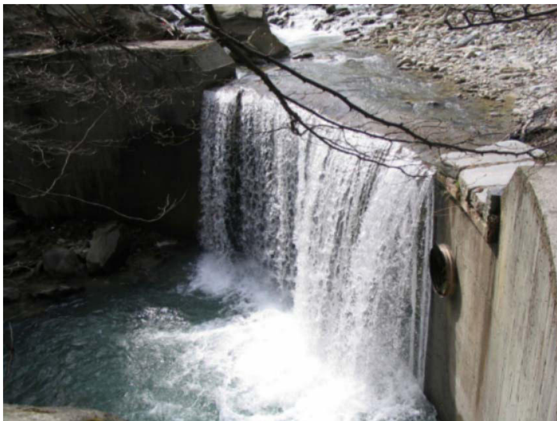
Foto 155 – Opera CANOBR001 . Ripresa laterale, sponda destra T. Luserna, affluente di destra del T. Pellice.
