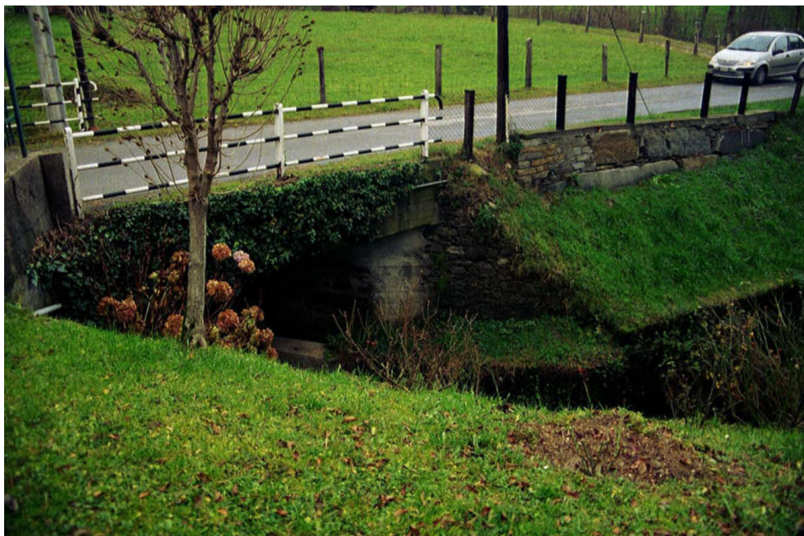
Foto 032 – Opera CANOAG024 . Ripresa da valle, sponda destra del R.dei Boer.
