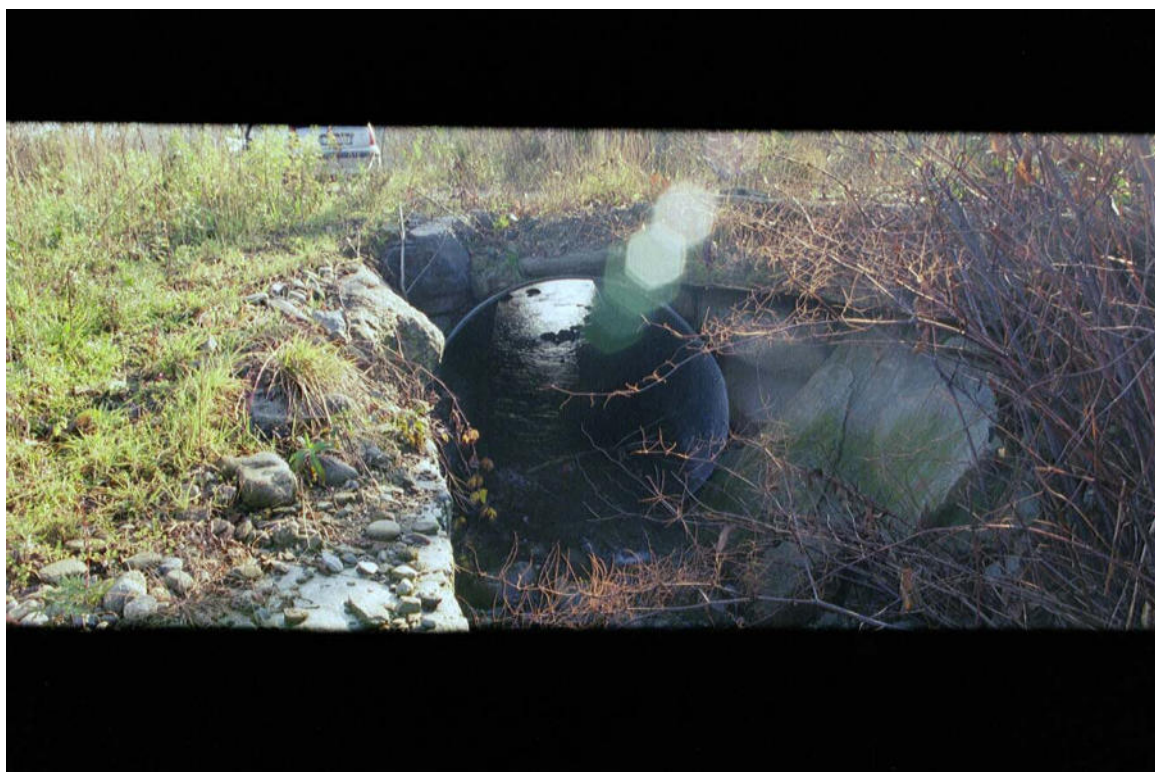
Foto 072 – Opera CANOAG063 . Ripresa da valle verso monte, Canale Comunale, affluente di sinistra del T. Pellice.
