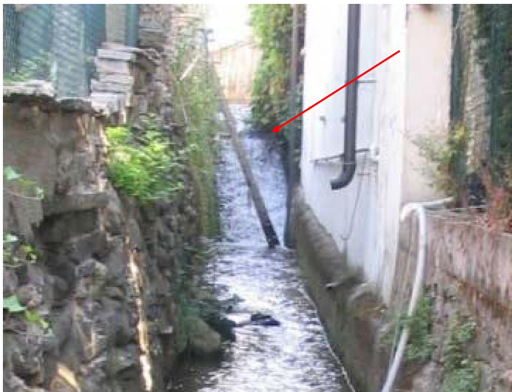
Foto 093 – Opera CANOSO021 . Ripresa da valle, Canale della Stazione.
