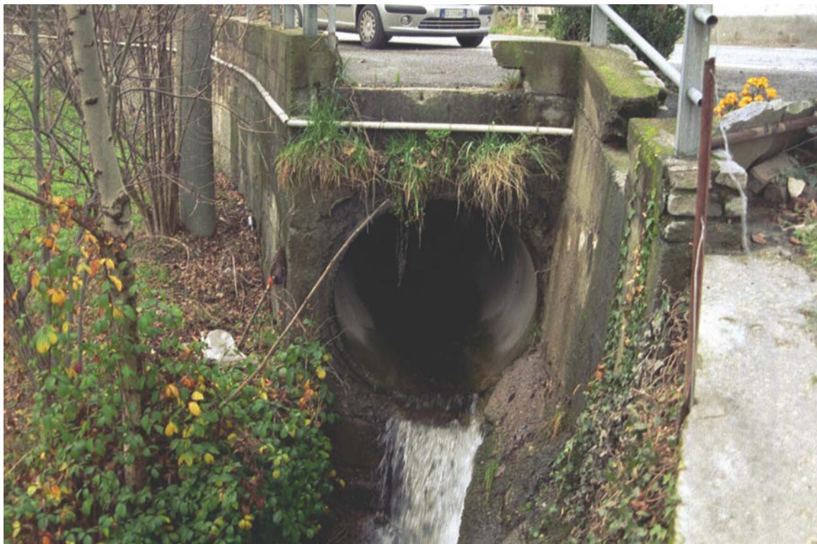
Foto 135 – Opera CANOCA005 . Ripresa da valle verso monte, Rio Cacciaira, affluente di sinistra del T. Luserna.
